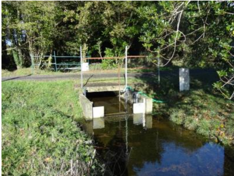
FIGURE 2.7 – Seuil à l'exutoire de Kervidy-Naizin.
