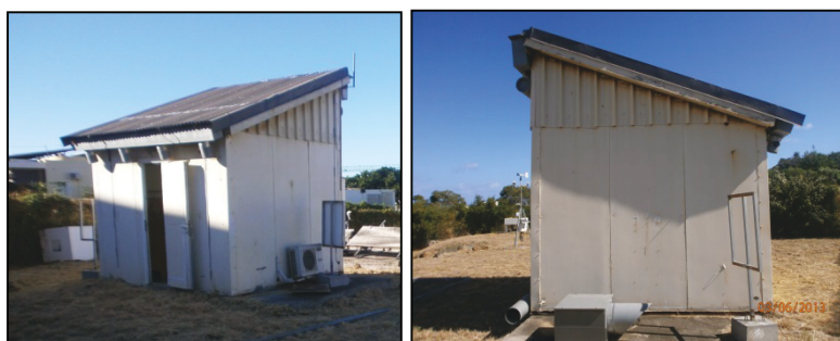
Figure 52 : Cellule LGI - Vues extérieures avant modification
