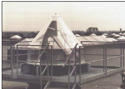
Figure 16 : Concentrateur lumineux actif du projet ARTHELIO (Rosemann and Kaase 2005)
