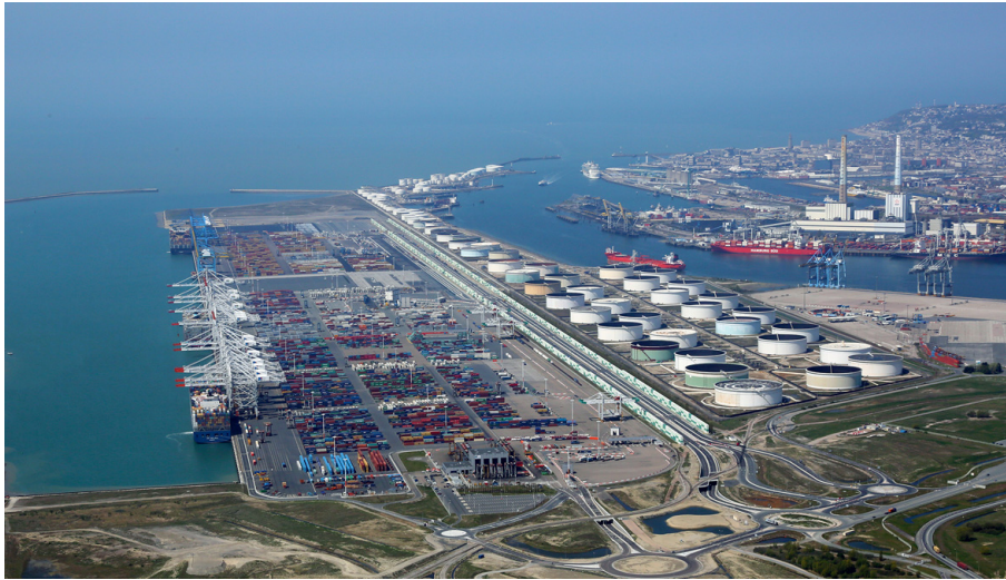
Figure III.1 – Vue sur Port2000
