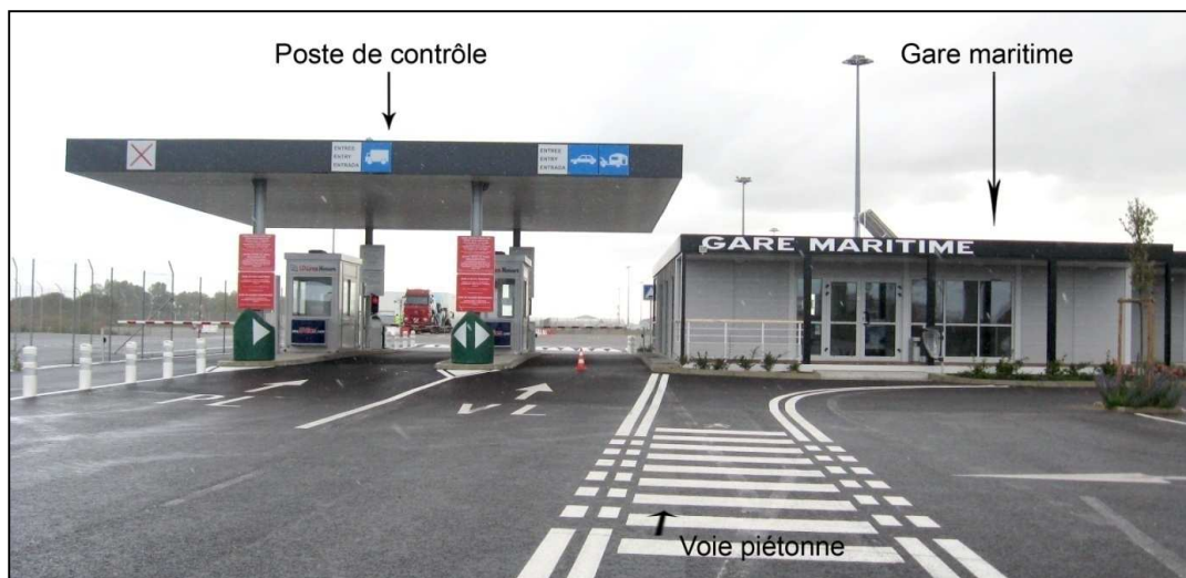
Figure 48 : Gare maritime et poste de contrôle
