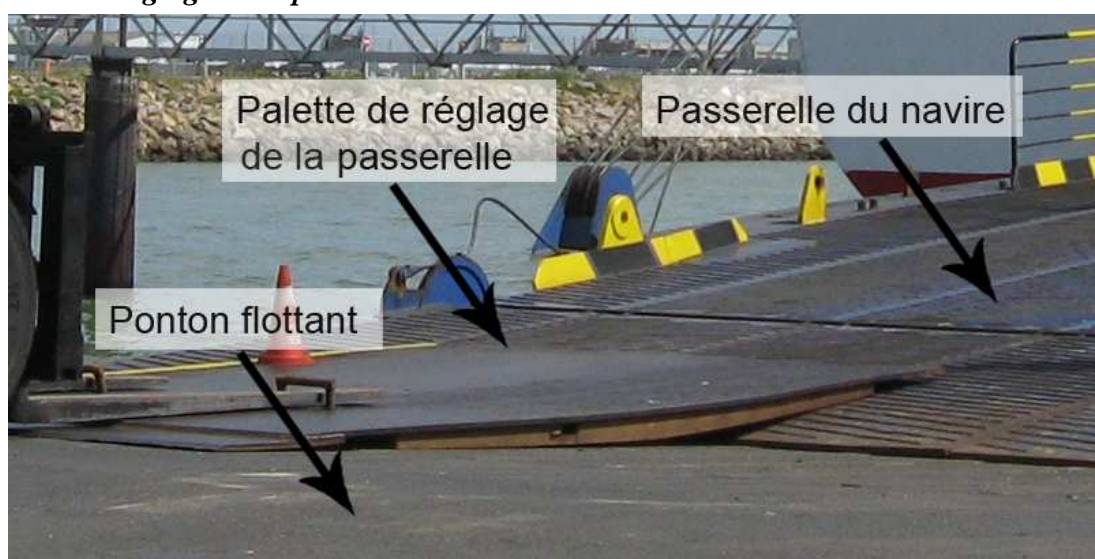
Figure 54 : Réglage de la passerelle du navire
