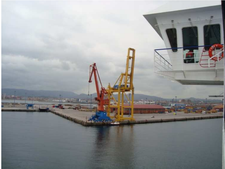
Poste du terminal roulier
