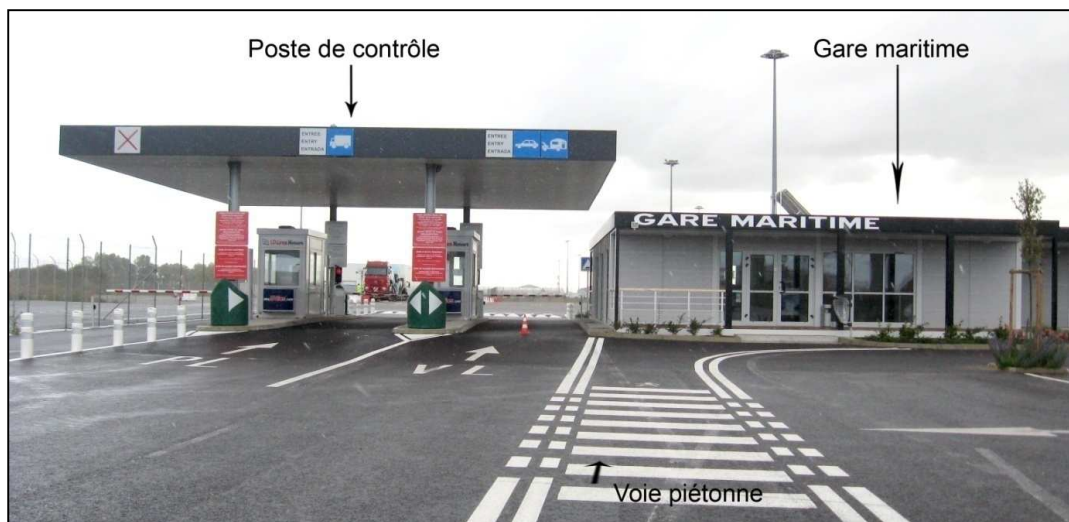
Figure 48 : Gare maritime et poste de contrôle
