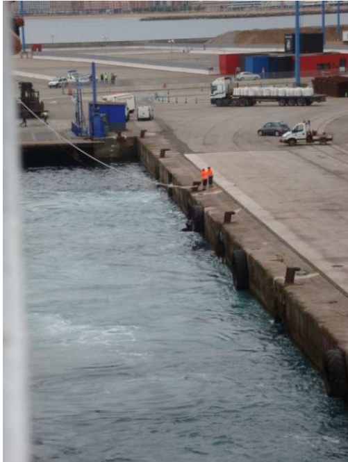
Equipements destinés à l'amarrage
