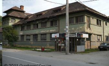
© 2011 Gurabarza/ Crișcior. Bâtiment de la Société minière de secours.
