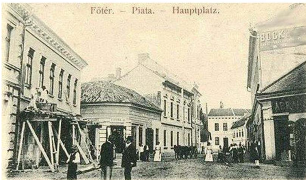
La place centrale de la ville (fin du XIX siècle). source: Primăria Municipiului Brad
