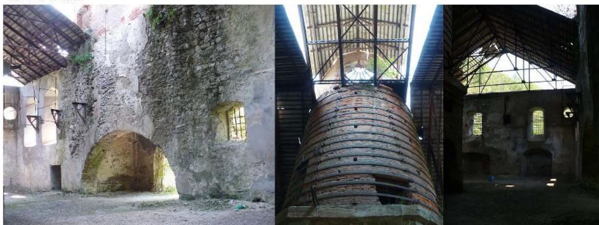
© 2013 Govăjdia. Vue de l'intérieur du haut fourneau (XIXe siècle).
