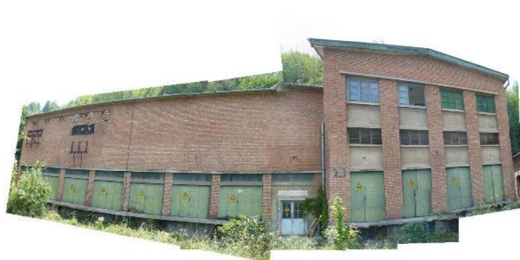
© 2013 Ghelari. Le transformateur électrique de l'ancien site minier de Ghelari.
