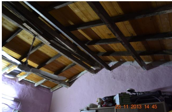
Fig. 87 et 88 : Deux exemples de maisons en adobe à Jéricho ayant remplacé la nappe de roseaux tissés par des panneaux de bois (Photo : Rania Daher, 2013).
