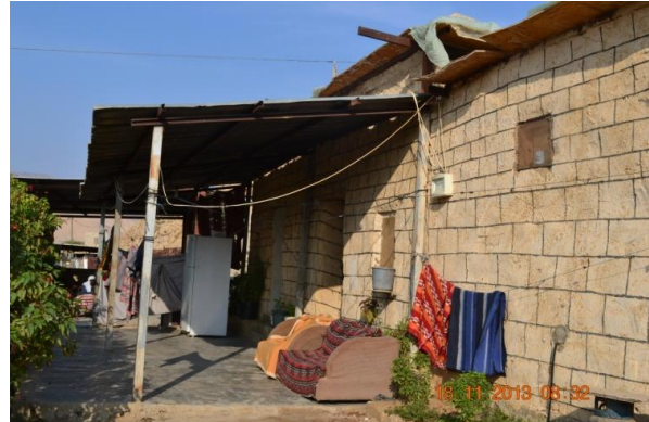
Fig.132 : Façade sud, façade principale de la maison Jiftlik 2 enduite en ciment. (Photo : Rania Daher, 2013)
