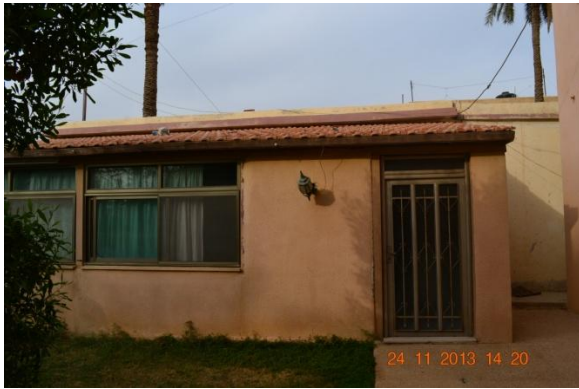
Fig. 79 : La partie de la maison Jéricho 15 en adobe, actuellement utilisée en espace de stockage (Photo : Rania Daher, 2013).
