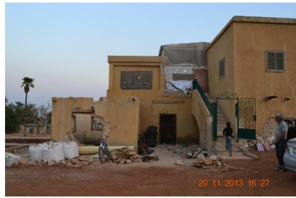
Fig. 93 : La maison Fasayel. Une partie de la façade sud en béton. (Photo : Rania Daher, 2013).
