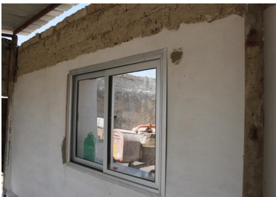
Fig. 138 : Typologie d'une maison du MA'AN DC. Les finitions de l'enduit et des ouvertures sont dans ce cas plus abouties. (Photo fournie par M. le coordinateur)
