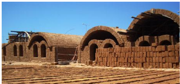
Fig.121 : Poste de police Sheikh Zayed construit en adobe 2009 (© Eva Bartlett, IPS)
