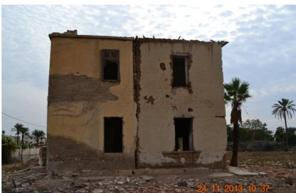
Fig. 81 : La maison Jéricho 12. Construite en adobe (partie droite), elle a subi une extension en béton (partie gauche) (Photo : Rania Daher, 2013).
