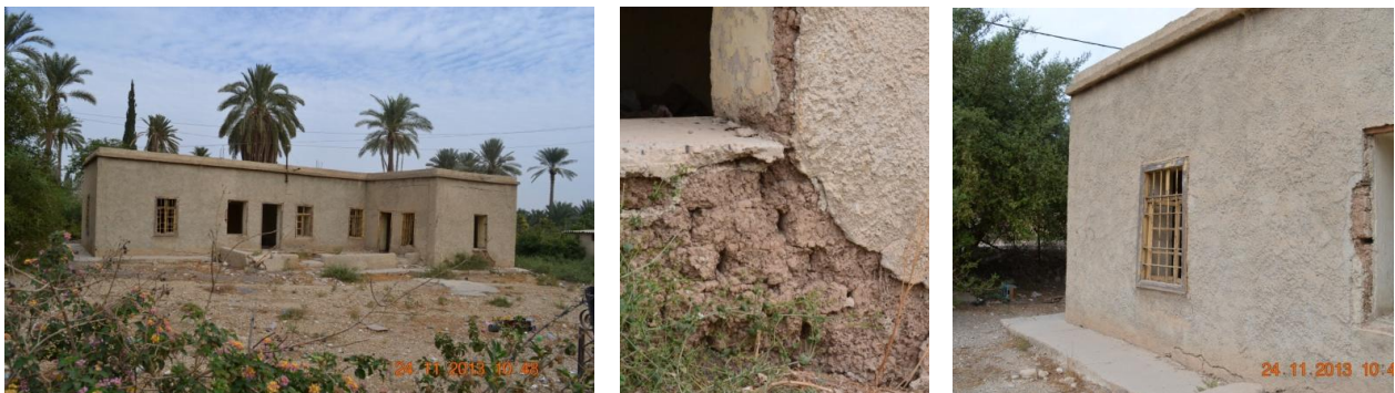
Fig. 96, 97 et 98 : La maison Jéricho 13. Construite en adobe, elle se caractérise par l'usage du béton et du ciment dans ses systèmes constructifs : toiture, fondation et enduit (Photo : Rania Daher, 2013).
