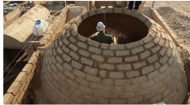
Fig. 150 et 151 : Construction d'une voûte (à gauche) et d'un dôme (à droite) sur le chantier du centre communautaire d'Aqbet Jaber. Architecte : Rashid Abdelhamid (© Rashid Abdelhamid).
