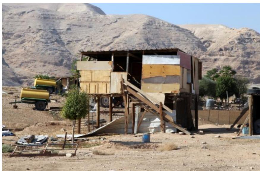
Fig.116 : Logement d'un Palestinien de la zone C, avec en arrière plan les réservoirs d'eau, car les Palestiniens ne peuvent se relier au réseau. (© Rashid Abdelhamid)
