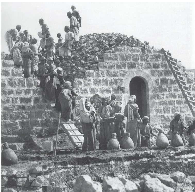
Fig. 35 : Chantier de construction d'un toit en dôme en pierre dans un village Palestinien à L'époque du mandat britannique. Nous remarquons la présence des femmes sur le chantier. Matson Collection, Library of Congress (Amiry et al, 1989).
