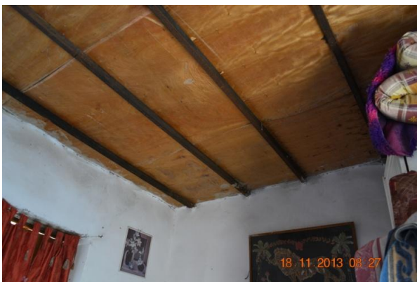
Fig.133 et 134 : Comparaison entre l'état de la toiture dans le séjour (à gauche) et dans la cuisine (à droite) de la maison Jiftlik 2. La structure légère de la toiture montre ici ses limites (Photo : Rania Daher, 2013)
