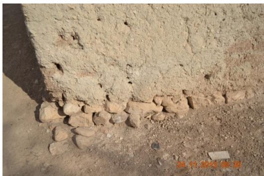
Fig. 50 : Fondations en pierre d'une maison en adobe à Jéricho construite avant 1920. (Photo : Rania Daher, novembre 2013).
