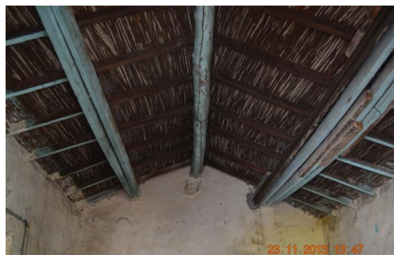
Fig. 85 et 86 : La maison Jéricho 7. Construite en adobe et en état de ruine, le toit à deux pentes est composé d'une structure bois habillée par une nappe de roseaux tissés (Photo : Rania Daher, 2013).
