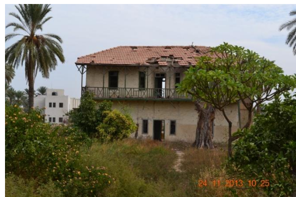
Fig. 90 : La maison Jéricho 11 en adobe. Actuellement en état de ruine. (Photo : Rania Daher, 2013).
