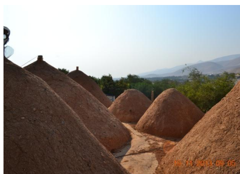
Fig.107 : Vue du toit de la maison Jiftlik 4. Le dôme conique est un cas particulier de la vallée du Jourdain (Photo : Rania Daher, 2013)
