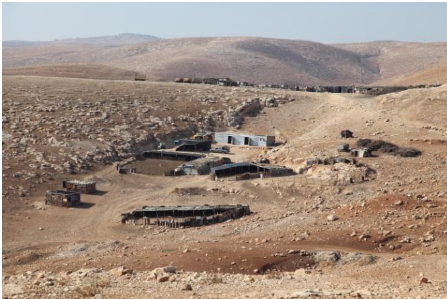
Fig.115 : Groupement palestinien de la zone C. Les habitants construisent avec des matériaux temporaires : bâches en plastique et tôle d'acier. (© Rashid Abdelhamid)
