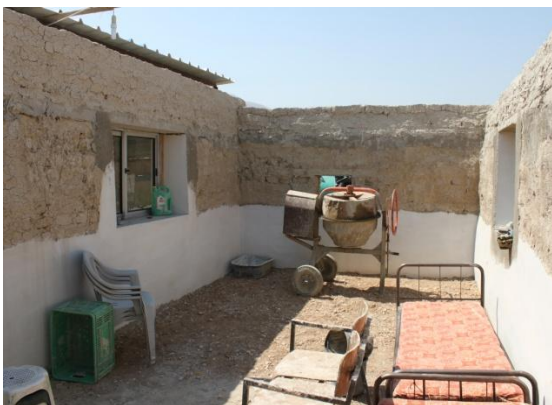
Fig. 137 : Typologie d'une maison du MA'AN DC. La maison se structure autour d'une cour et comprend un chaînage en béton pour assurer sa stabilité. (Photo fournie par M. le coordinateur)
