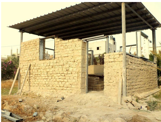
Fig. 140 : Structure en adobe construite par El Auja environmental center. Les murs en adobe ne sont pas porteurs (Photo fournie par le centre).
