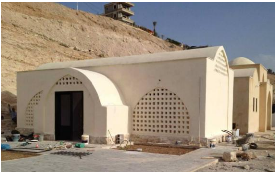
Fig. 163 : Restaurant en BTC à el Dyouk. Présence de Moucharabieh en adobe sur la façade. Agence d'architecture Shams-Ard. (© Shams-Ard)
