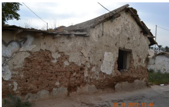
Fig. 85 et 86 : La maison Jéricho 7. Construite en adobe et en état de ruine, le toit à deux pentes est composé d'une structure bois habillée par une nappe de roseaux tissés (Photo : Rania Daher, 2013).
