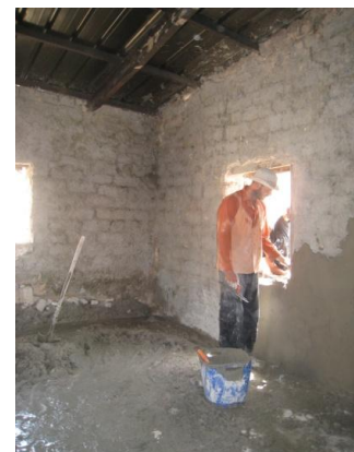
Fig. 139 : Mise en place de l'enduit en ciment par le MA'AN DC. (Photo fournie par M. le coordinateur)
