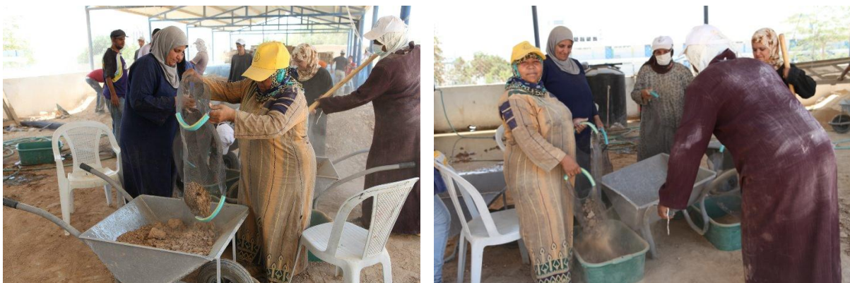
Fig. 146 et 147 : Phase de tamisage effectuée par les femmes sur le chantier du projet de centre communautaire d'Aqbet Jaber. (© Rashid Abdelhamid)
