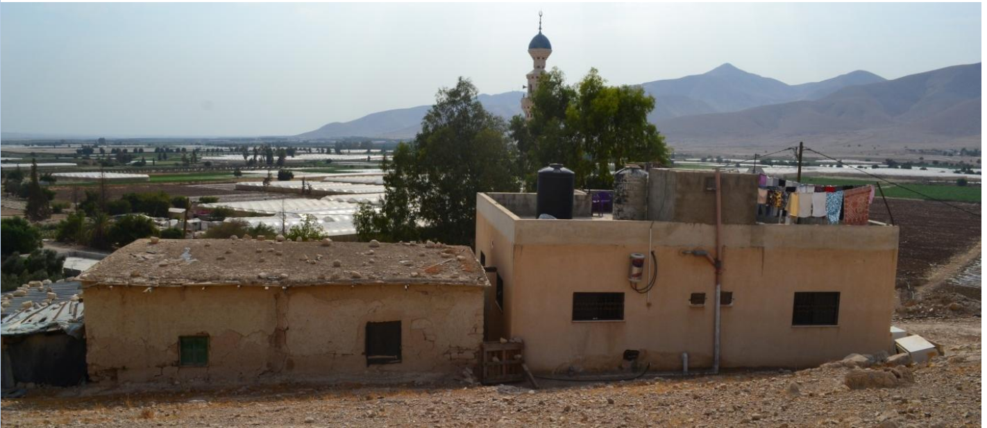
Fig. 77 : Façade nord de la maison Jiftlik 1 (Photo : Rania Daher, 2013)
