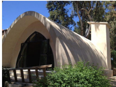
Fig. 164 : Musée de l'écologie en BTC à Ramallah. Présence de la tour à vent. Agence d'architecture Shams-Ard. (© Shams-Ard)
