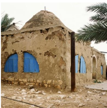
Fig.106 : La maison Jiftlik 4 avant restauration. (© Rashid Abdelhamid)
