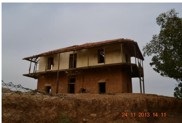
Fig. 89 : La maison Jéricho 9. En adobe, elle est construite sur deux niveaux avec une toiture en tuile (Photo : Rania Daher, 2013).
