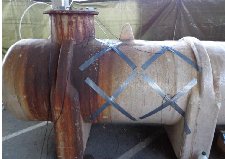
Figure 3-66 Essai de corrosion sur structure industrielle réalisé par CYBERNETIX
