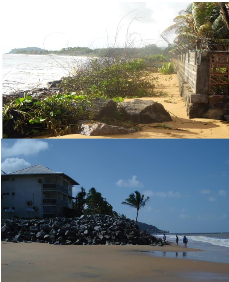
Figure 5.7: Enrochements disposés sur le haut de plage à Cayenne pour protéger les habitations.
