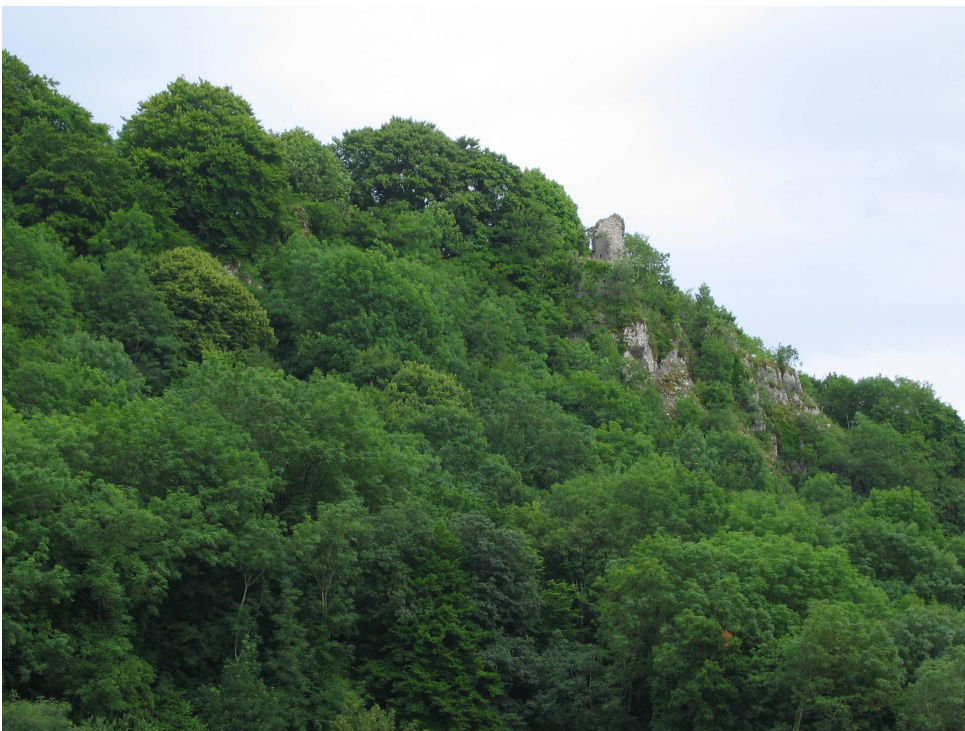
Site du château de Binans.
