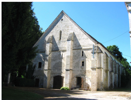
Abbaye cistercienne de Longuey, (Aubepierre-sur-Aube) : l'ancien bâtiment des frères convers (36.60 m x 20.10 m). Construite près d'un gué de l'Aube.
