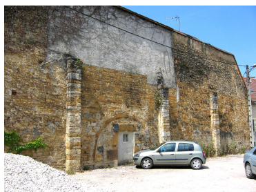
Mur du couvent des Cordeliers.
