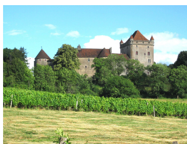
Château du Pin, vue générale.
