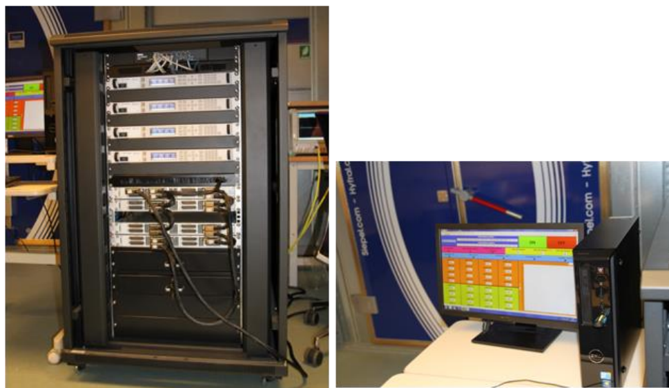
Figure 95 : Photographie du banc de pilotage de tensions continues.
