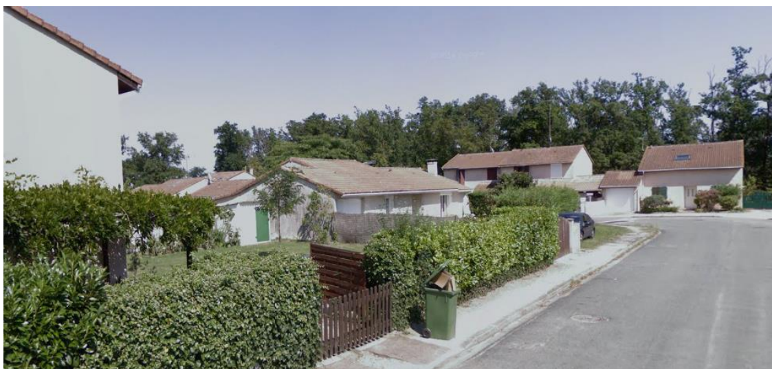
Figure 65: L'habitat pavillonnaire dans le quartier Ouest de Parempuyre
