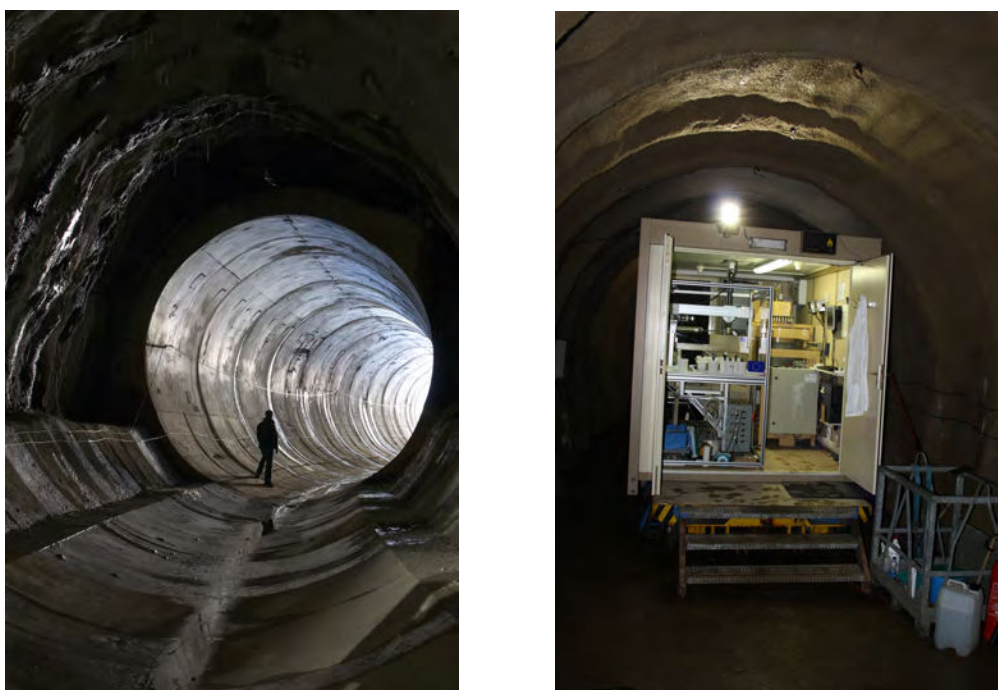
FIGURE 3.11 – A gauche : Tunnel EDF de Ferrières (Ariège, Pyrénées) hébergeant le laboratoire LAFARA. A droite : Algéco abritant les deux détecteurs gamma
