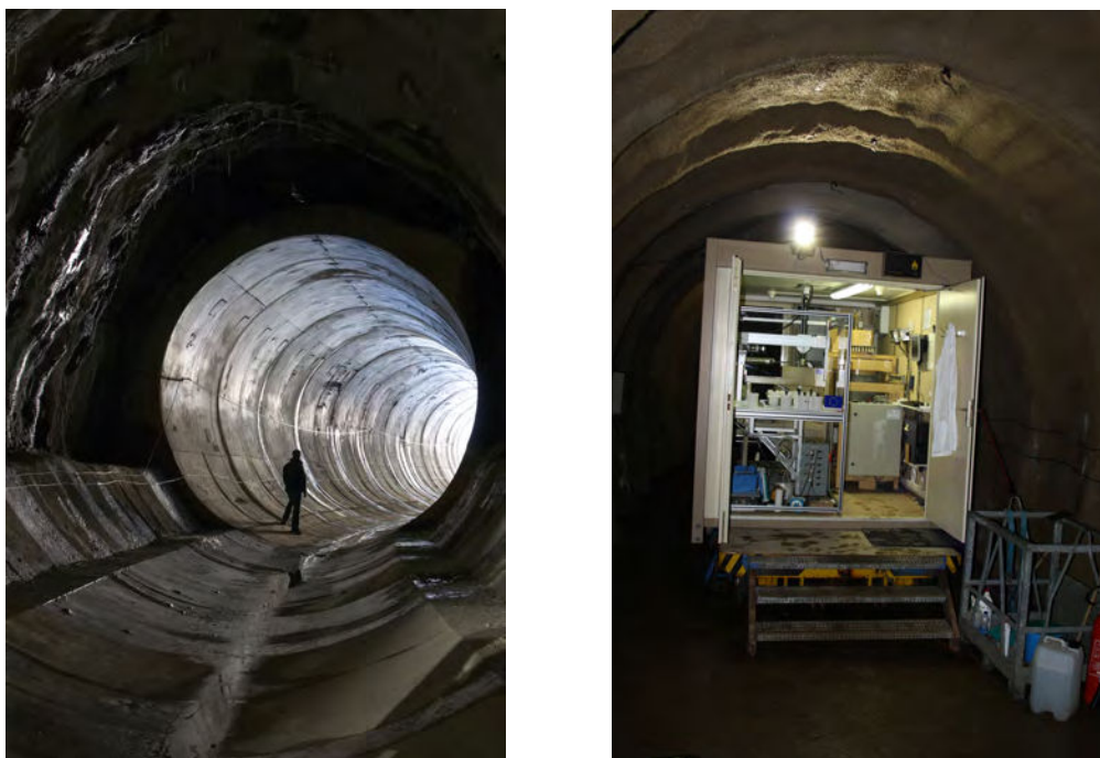
FIGURE 3.11 – A gauche : Tunnel EDF de Ferrières (Ariège, Pyrénées) hébergeant le laboratoire LAFARA. A droite : Algéco abritant les deux détecteurs gamma
