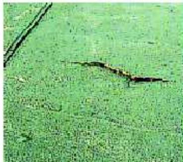
FIGURE 2.6: Déchirement de la membrane de l'isolant suite à un écrasement local [57].
