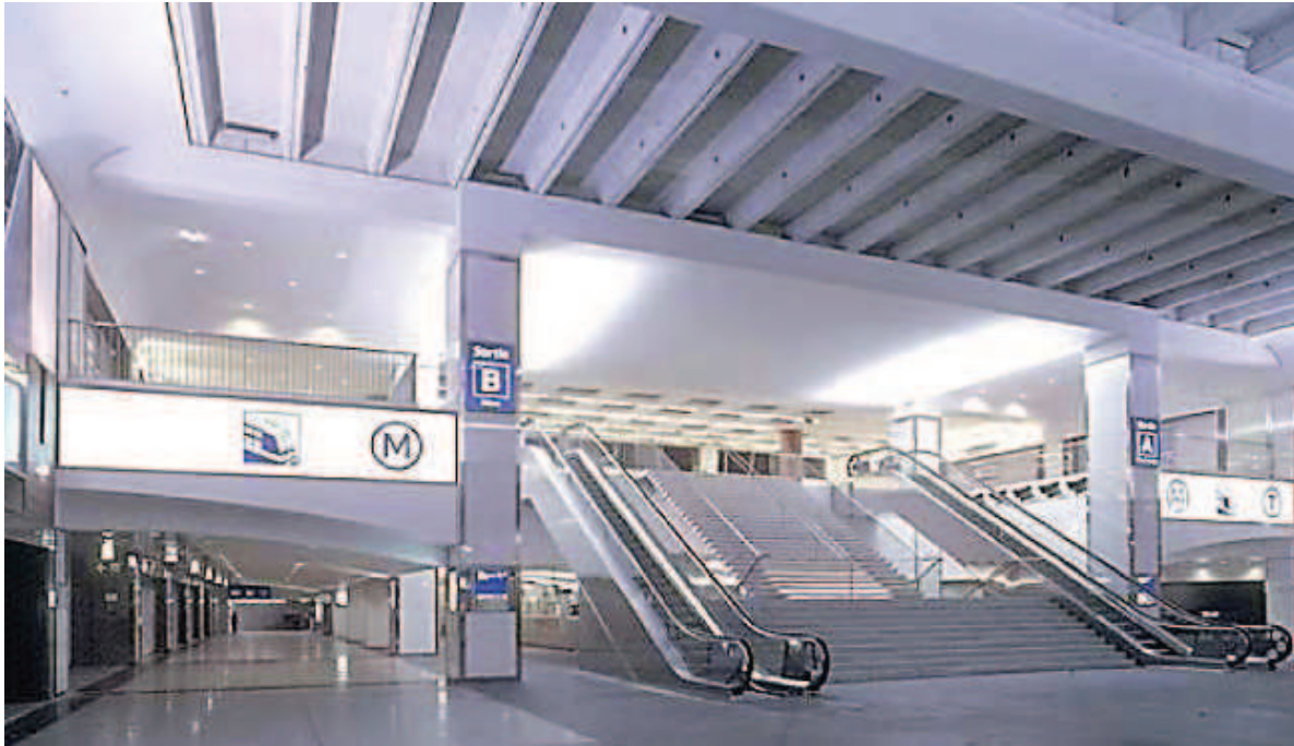
Figure 103 : vue de la grande salle des échanges du "Cœur Transport" de la Défense 292
