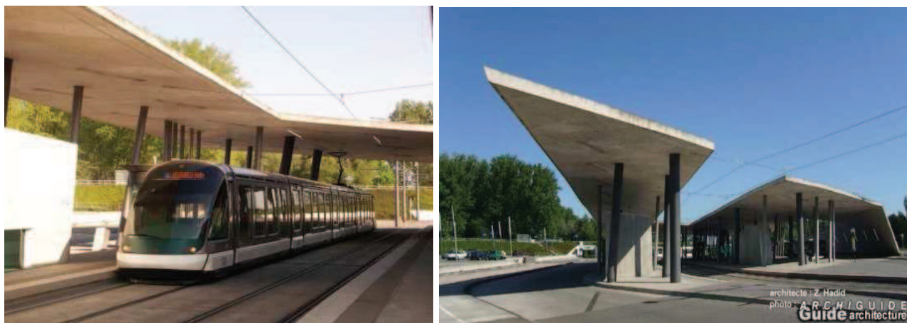
Figure 117 (à gauche) : une rame EUROTRAM au terminus "Hœnheim- Gare" du réseau de la CTS (ligne B). Figure 118 (à droite) : PEM d' « Hœnheim-Gare », dessiné par l'architecte Zaha HADID.
