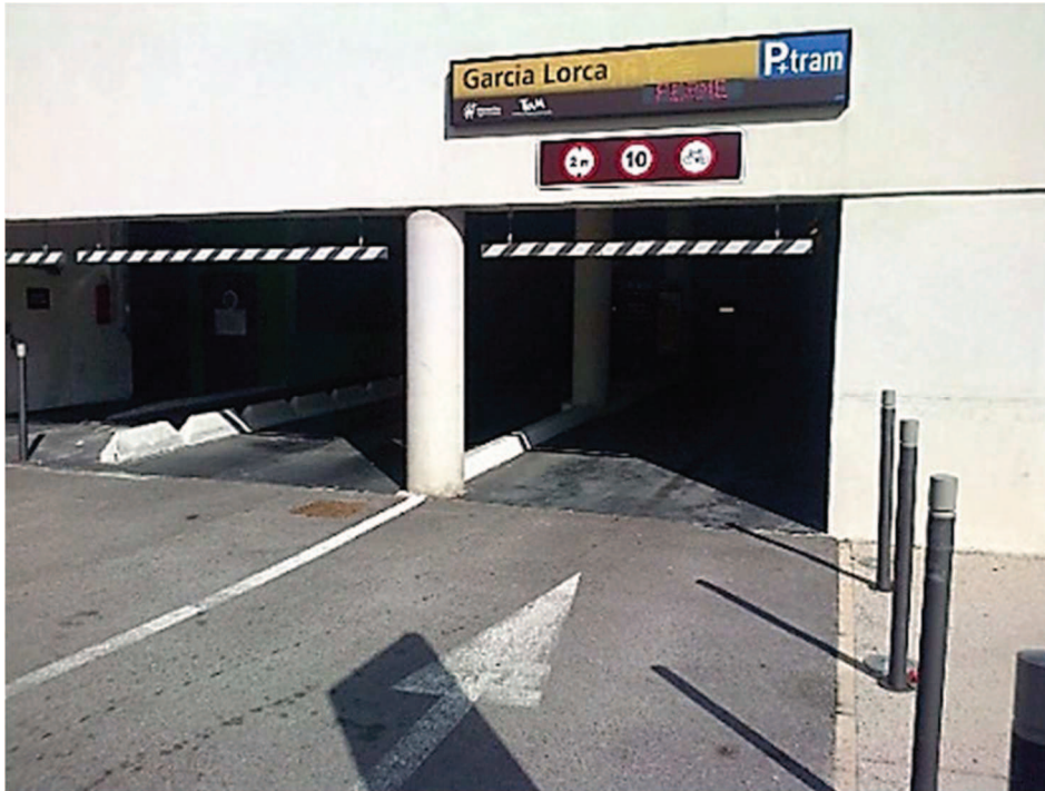
Figure 77 : entrée du PEM « Garcia Lorca » depuis l'Avenue de Palavas.
