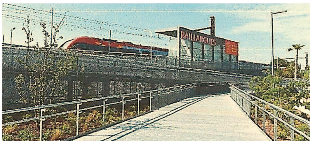
Figure 67 : rampe d'accès aux quais (accessible aux PMR) 229 .
