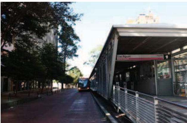
Figure 146 (à gauche) : station de type « sencilla ».
