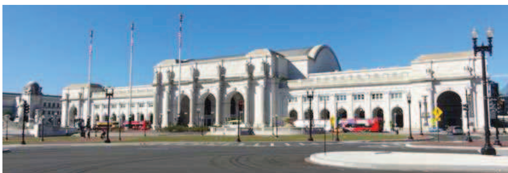
Figure 50 : façade extérieure la gare Union Station de Washington DC 211 .
