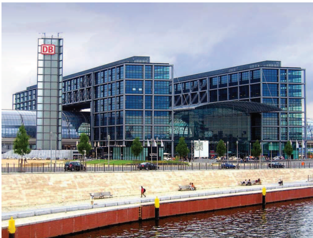
Figure 53 (ci-dessus): vue extérieure de la gare centrale de Berlin 216
