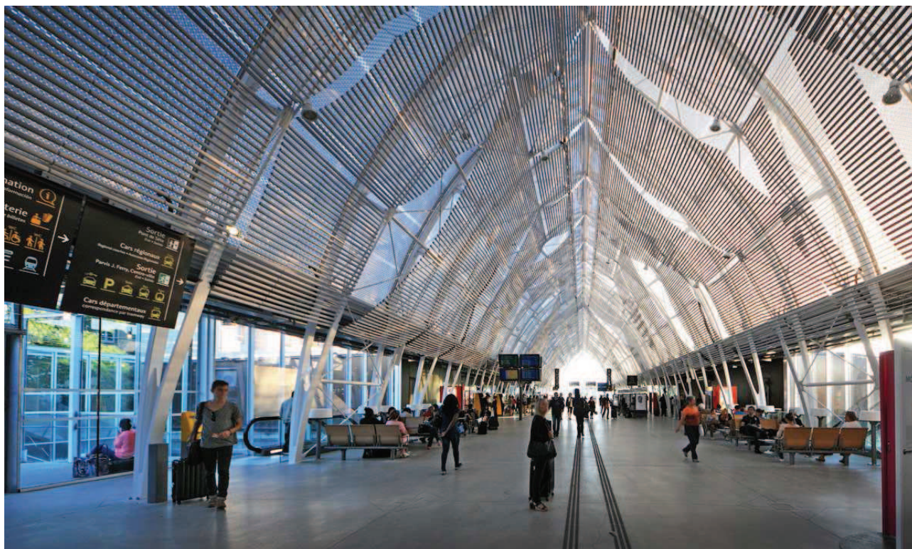
Figure 27 : vue de l'intérieur de la Nef de la gare de Montpellier Saint-Roch 172 . © AREP.
