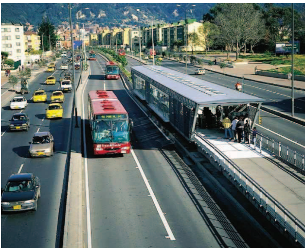
Figure 148 (à gauche) : site propre du « Transmilenio » et station implantée à proximité. 355
