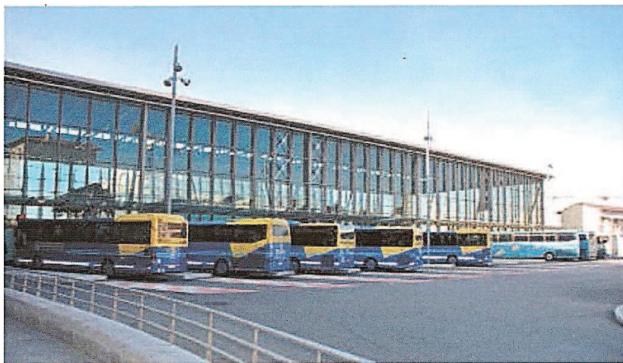
Figure 29 : vue générale de la nouvelle gare routière du PTMSC 175
