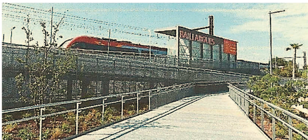
Figure 67 : rampe d'accès aux quais (accessible aux PMR) 229 .
