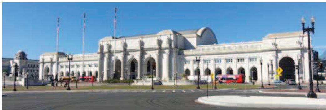
Figure 50 : façade extérieure la gare Union Station de Washington DC 211 .
