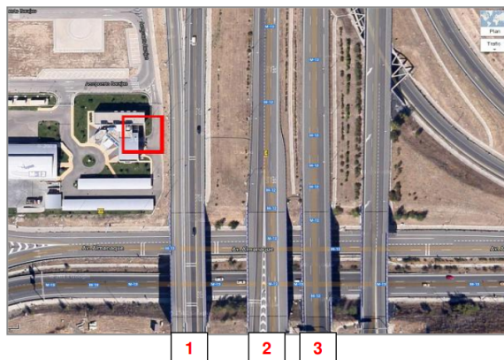
FIGURE 3.5 – Vue zoomée sur le site de test de l'autoroute M-12
