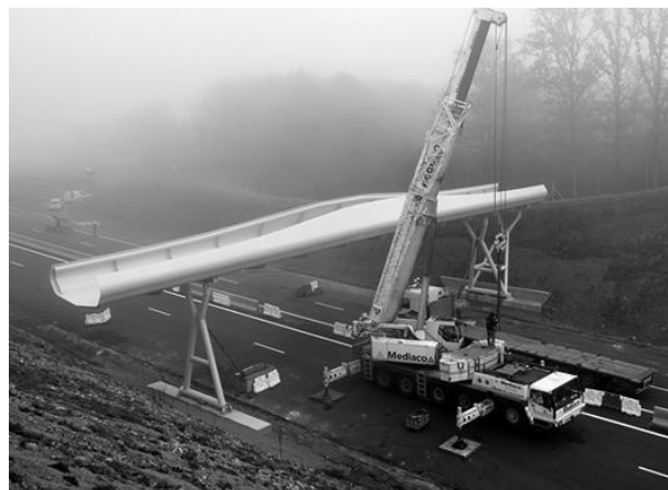
Fig. 35 : Installation d'un chiropteroduc sur l'A89 (Source : www.denisriou.com [Consulté le 26 octobre 2013])
