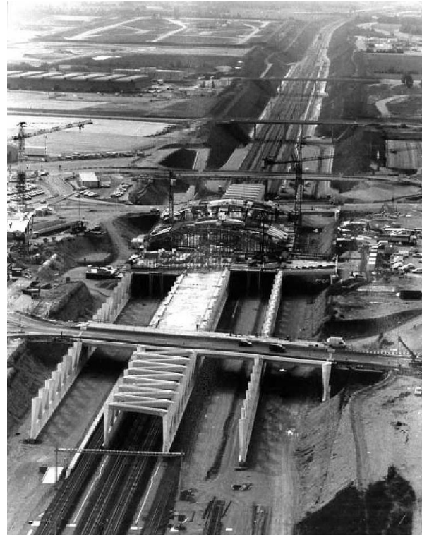
Fig. 14 : Travaux de construction de la gare TGV Lyon-Satolas en 1992 (Source : Audal, 2012c, p.72)
