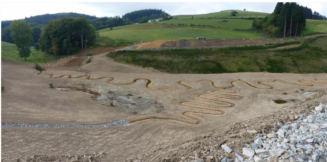
Fig. 89 : Travaux de restauration écologique aux abords de l'A89 (Source : Audal, Epures, 2013c)
