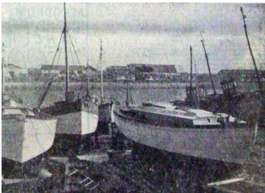
FIGURE 2.18 – La cale du chantier Vernazza et ses bateaux 336
