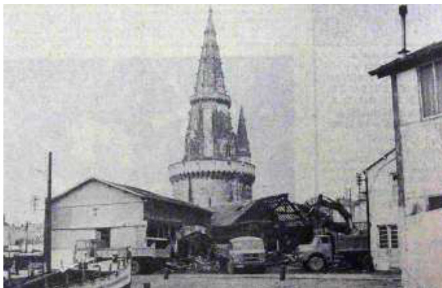
FIGURE 6.6 – La rue des chantiers lors de sa destruction, 1972 850
