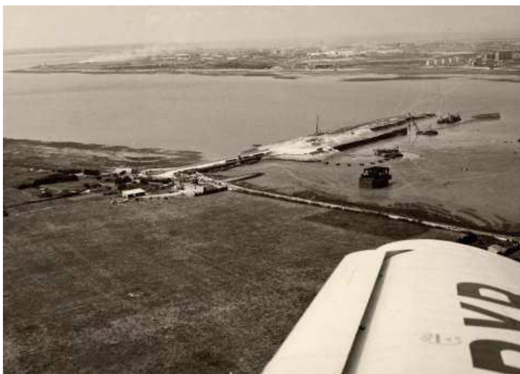
FIGURE 4.12 – Les entreprises Truchetet-Tansini et Voisin commencent les travaux d'aménagement du port de plaisance (1970) 627
