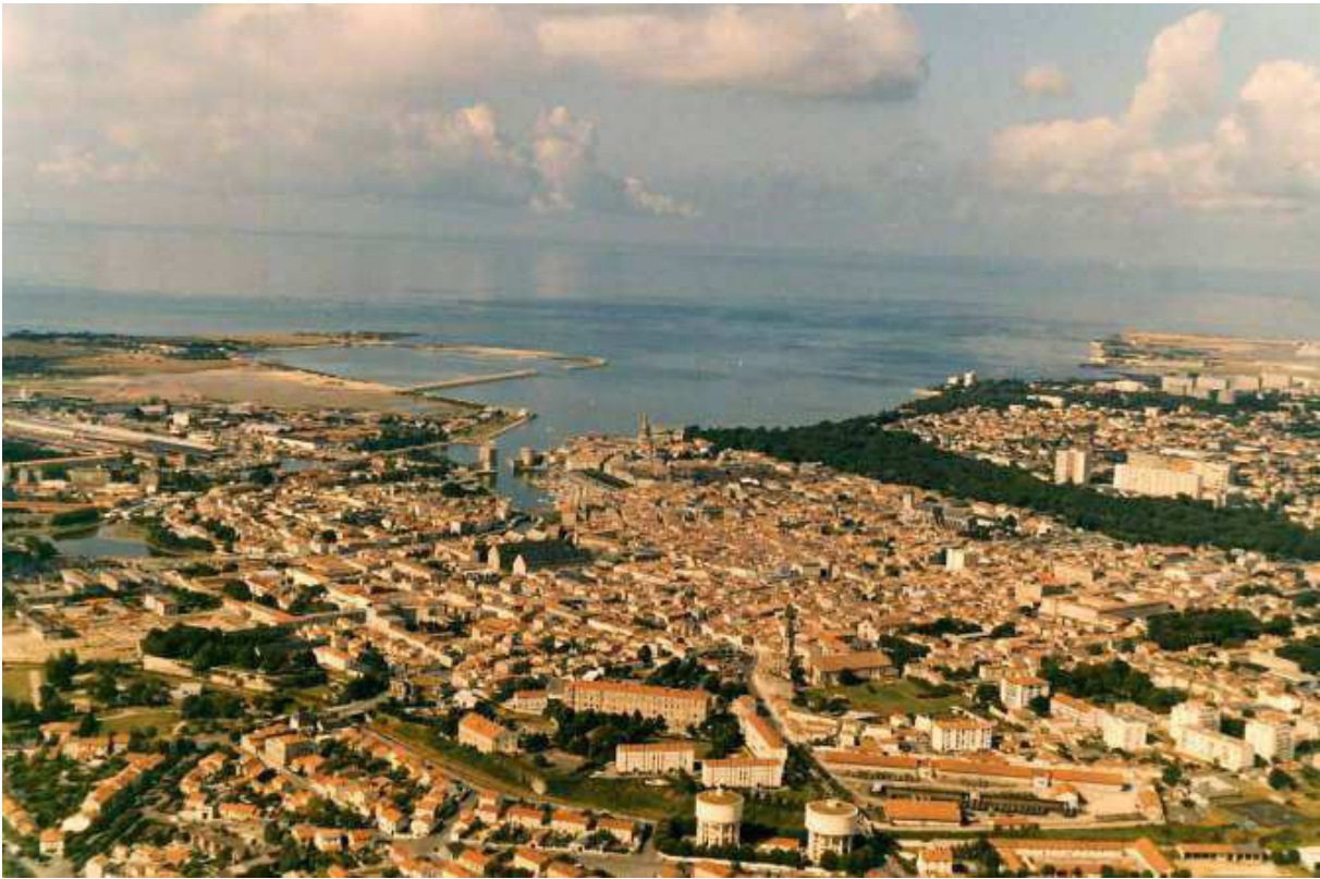
FIGURE 6.3 – Vue aérienne de La Rochelle, juillet 1971 803
