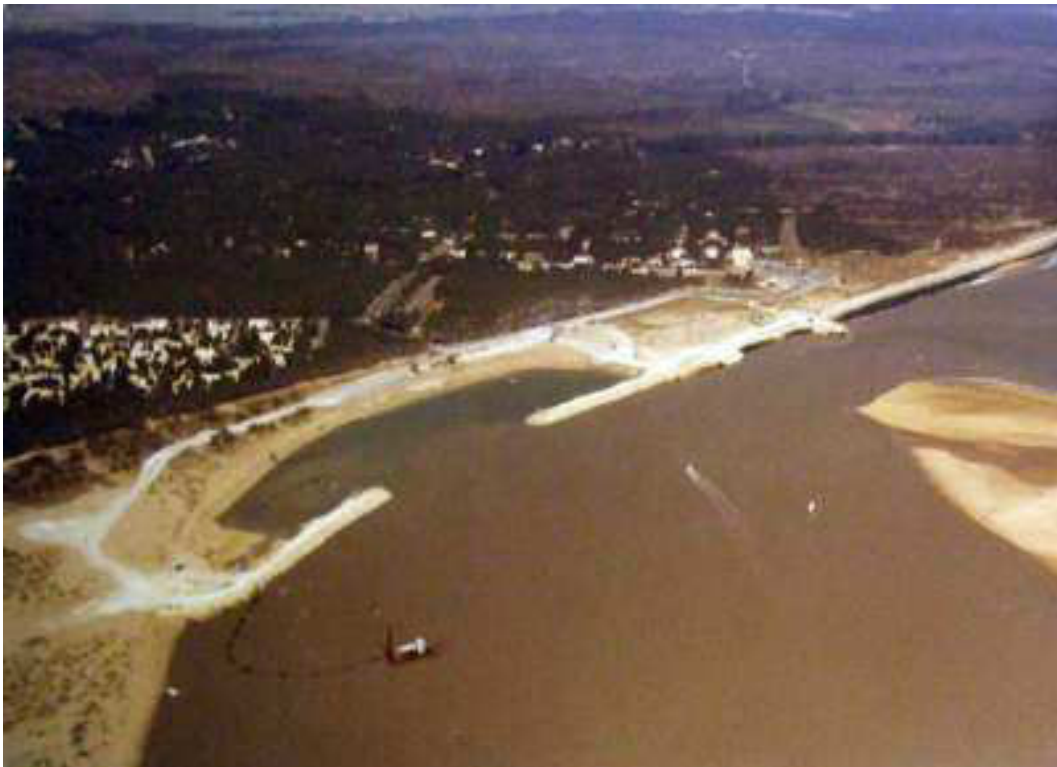
FIGURE 8.9 – Vue aérienne des travaux de défense de la côte, 1977 1003
