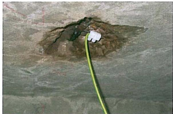
Photo 40 : Les connections entre armatures ont été vérifiées et en environ tous les 1m<sup>2</sup>, les armatures ont été connectées à un générateur de courant électrique.
