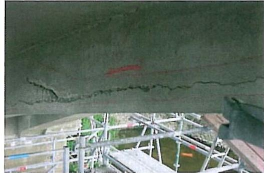
**Photo 10 :** Sur quelques poutres des gonflements ont été observés sur des surfaces assez considérables.
