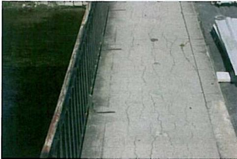
**Photo 3 :** Fissures visibles sur les trottoirs.
