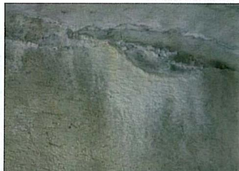
**Photo 6 :** Présence de concrétions blanches en sous-face du tablier.
