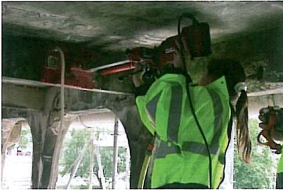
**Photo 21** : Prélèvement par carottage.
