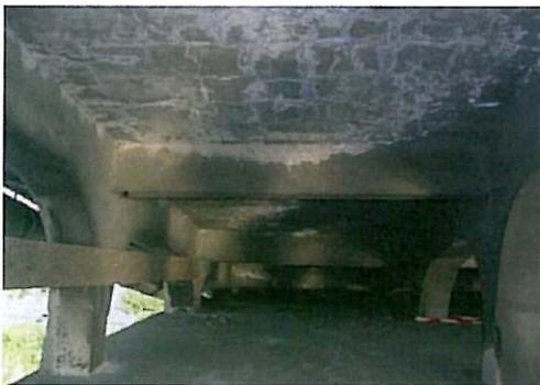
**Photo 5 :** Nombreuses traces d'infiltration en sous-face du tablier.
