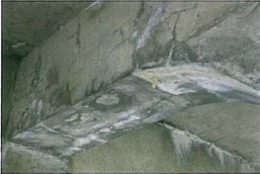
**Photo 9 :** Des infiltrations d'eau, localement associées à des stalactites blanches ou ocre sont visibles au niveau des poutres.
