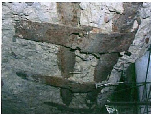
**Photo 13 :** Localement les étriers sont rongés par la corrosion jusqu'à la rupture.
