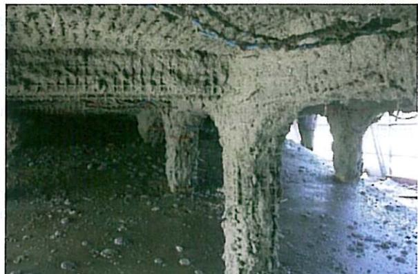
Photo 42 : Une pulpe de papier imbibée d'un électrolyte alcalin a été projetée à la surface du béton, enrobant l'anode en acier fixée temporairement à la surface du béton.
