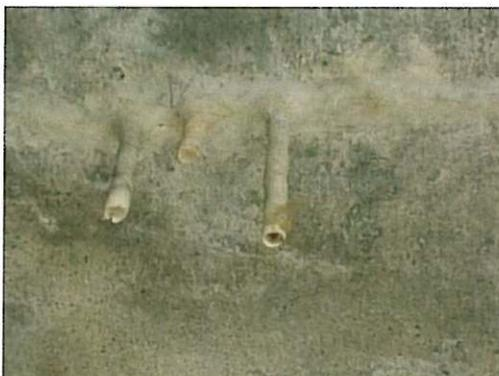
**Photo 7 :** Localement des stalactites blanches ou ocre sont visibles en sous-face du tablier.
