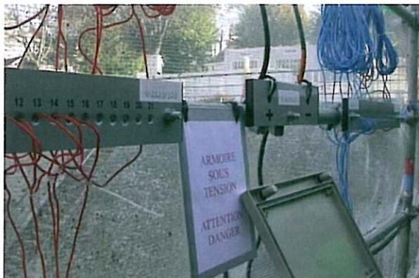
Photo 41 : Environ tous les 1m<sup>2</sup>, les armatures, ainsi que l'anode en acier fixée temporairement à la surface du béton ont été connectées à un générateur de courant électrique.
