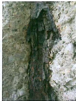
**Photo 24**: Epaufrure visible en zone 1, laissant apparaître une armature très corrodée.
