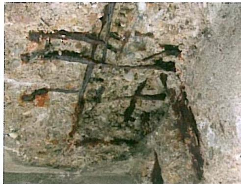
**Photo 8 :** Présence de nombreuses épaufrures laissant apparaître des armatures très corrodées en sous-face du tablier.
