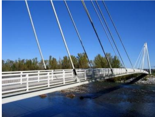
Figure 25. Photographie de la passerelle de Laroin dont les haubans ont été réalisés en fibres de carbone et matrice époxy. (Photo : Romain Mounetou)
