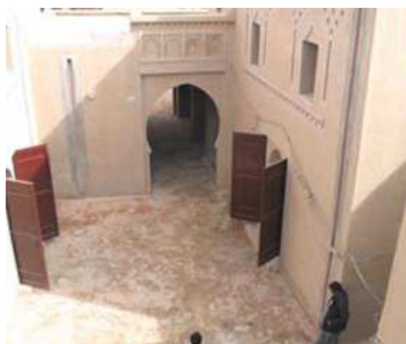
Photo 5 : Ksar Jrana, après sa restauration
