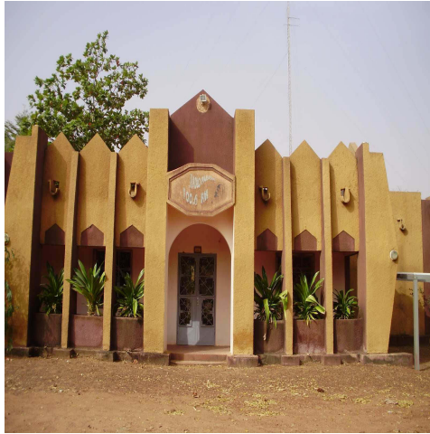
1. Entrée de la station de Radio Parana
