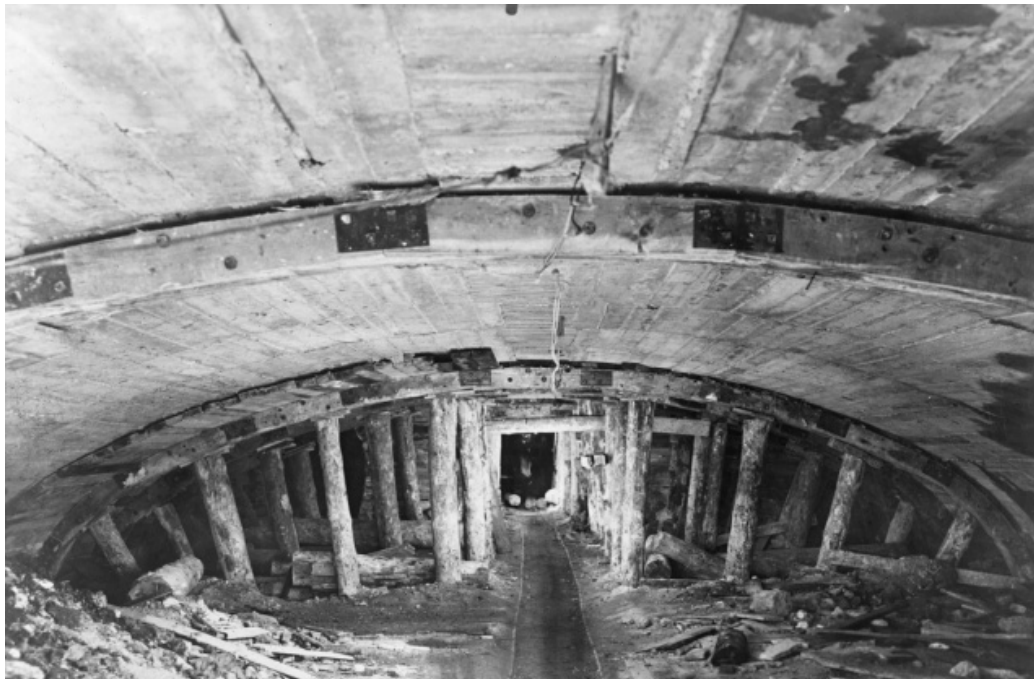
Figure 1.17 Quatrième phase – Maçonnerie de la voûte achevée dans le chantier de construction de la ligne 9 du métro en 1933 ©RATP
