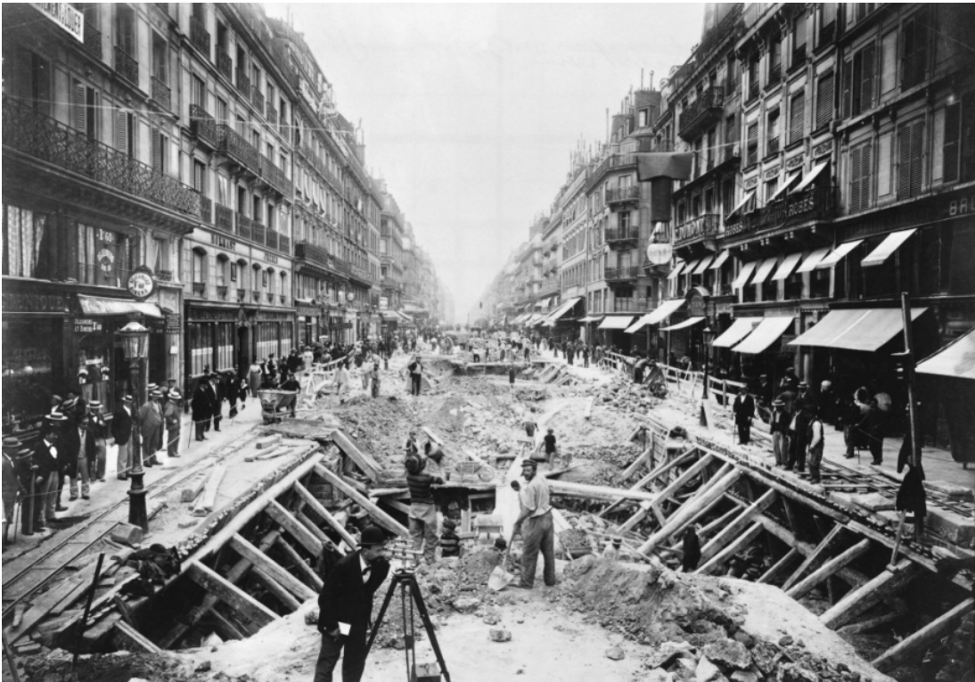
Figure 1.8 Chantier de construction de la ligne 1 du métro, rue de Rivoli en 1899. Reproduction Archives Mairie de Paris
