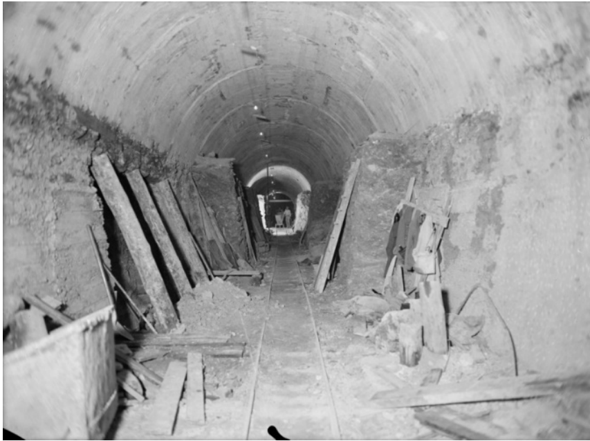
Figure 1.21 Sixième phase – Construction des pénétrations, dans la création du raccordement des lignes 12 et 14 du métro à Montparnasse en 1935 ©RATP
