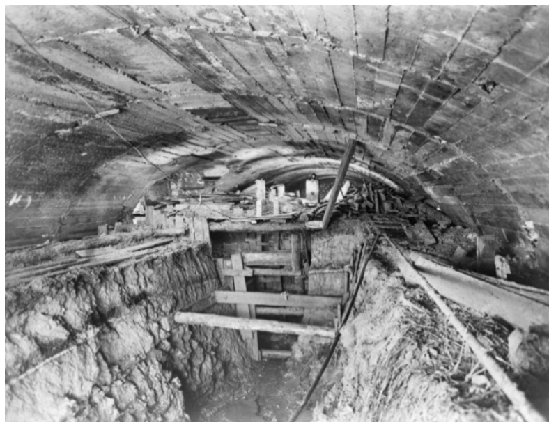
Figure 1.19 Cinquième phase – Creusement de la tranchée « stross » dans le chantier de construction de la ligne 9 du métro en 1933 ©RATP
