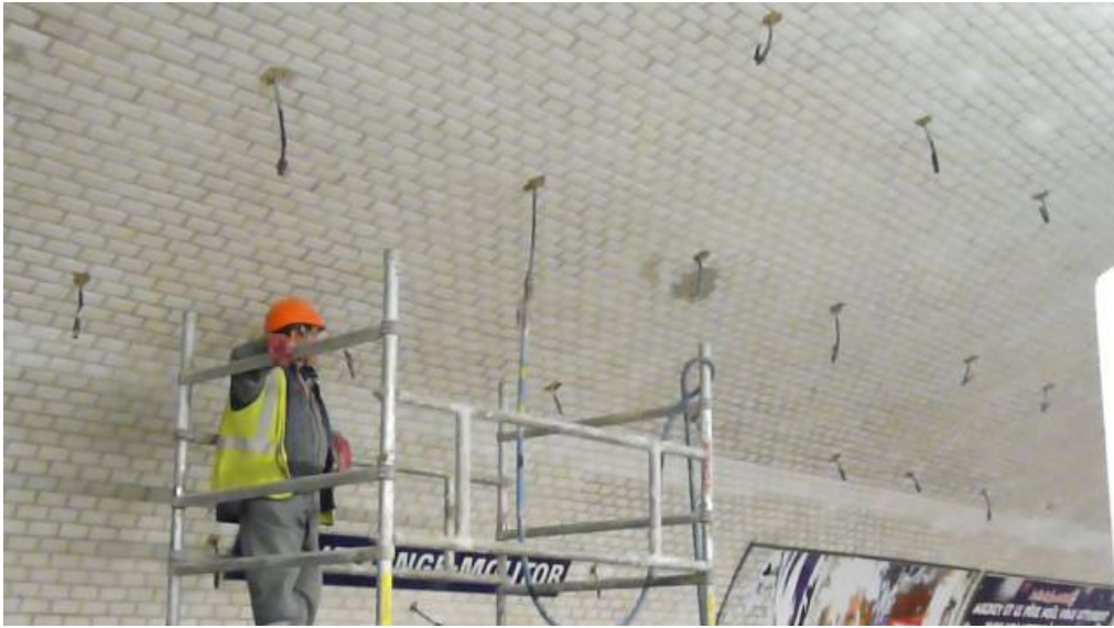
Figure 1.31 Travaux de régénération par injection dans un tunnel.
