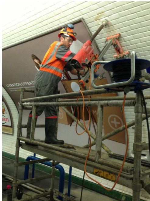
Figure 4.2 Extraction des carottes dans la station Pereire sur la ligne 3
