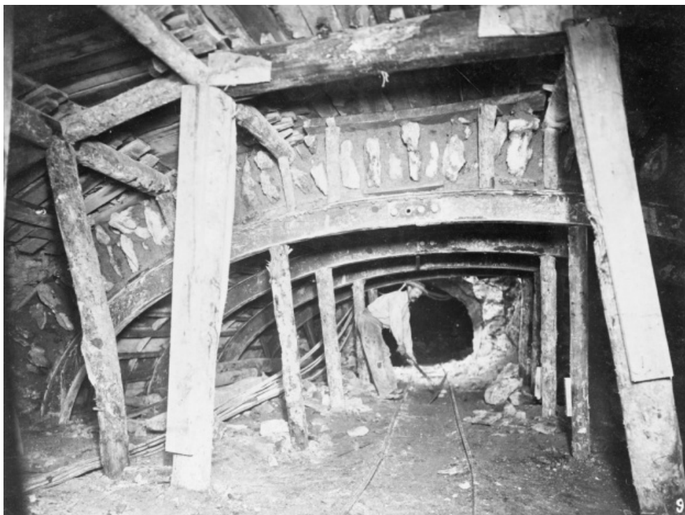
Figure 1.15: Troisième phase – Construction de la voûte, dans le chantier sous le boulevard de Strasbourg en 1905. Reproduction Archives Mairie de Paris
