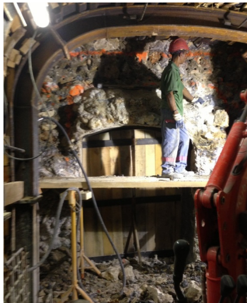
b) Création d'une ouverture au niveau des pieds droits, attaque par l'extérieur du tunnel
