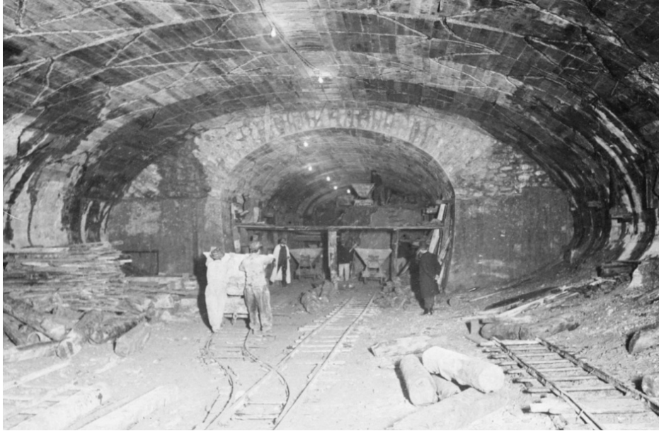
Figure 1.23 Septième phase – Chantier de construction de la station Martin Nadaud (aujourd’hui Gambetta) en 1904. Reproduction Archives Mairie de Paris
