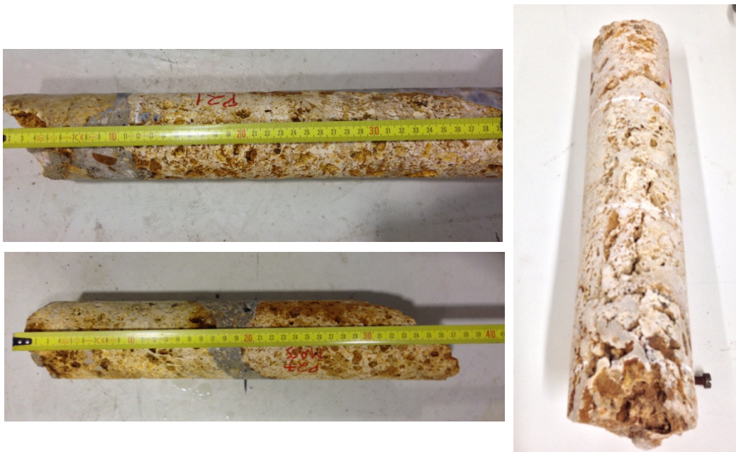
Figure 4.6 Carottes de maçonnerie de 73 mm de diamètre. Blocs de meulière, d'une taille allant de 5 cm à 30 cm de longueur
