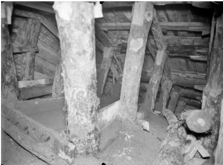
Figure 1.13 Deuxième phase – Abattage du tunnel lors de la création du raccordement des lignes 4 et 12 du métro à Montparnasse en 1934 ©RATP
