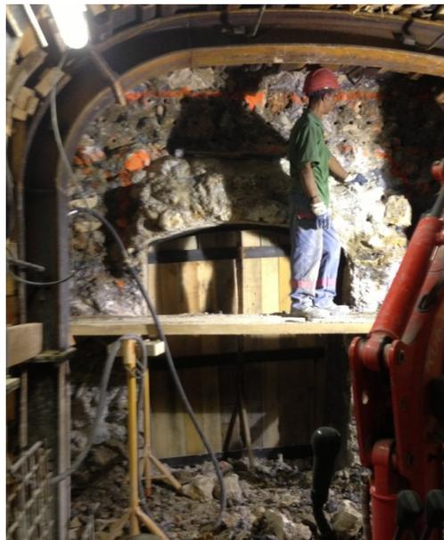
b) Création d'une ouverture au niveau des pénétrations, attaque par l'extérieur du tunnel
