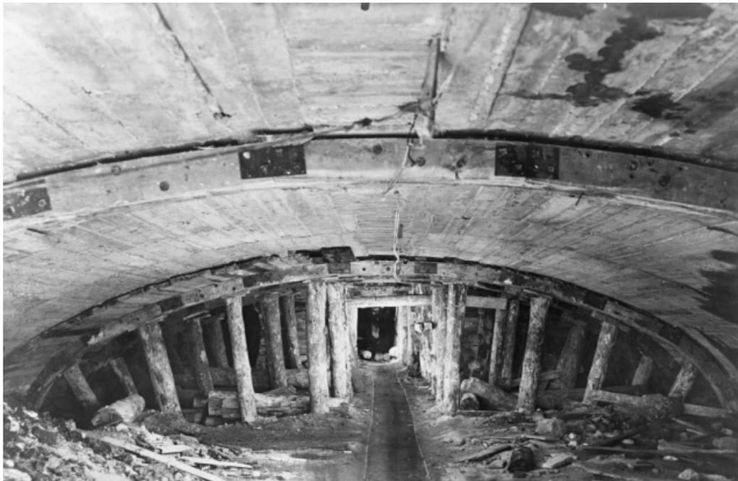
Figure 1.17 Quatrième phase – Maçonnerie de la voûte achevée dans le chantier de construction de la ligne 9 du métro en 1933 ©RATP
