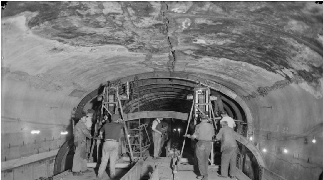
Figure 1.26 Fissuration en clé de voûte. Photo : travaux de renforcement du tunnel vers la station Obligado de la ligne 1 (aujourd'hui Argentine) en 1946. ©RATP.
