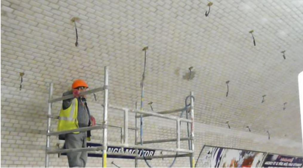
Figure 1.31 Travaux de régénération par injection dans un tunnel.
