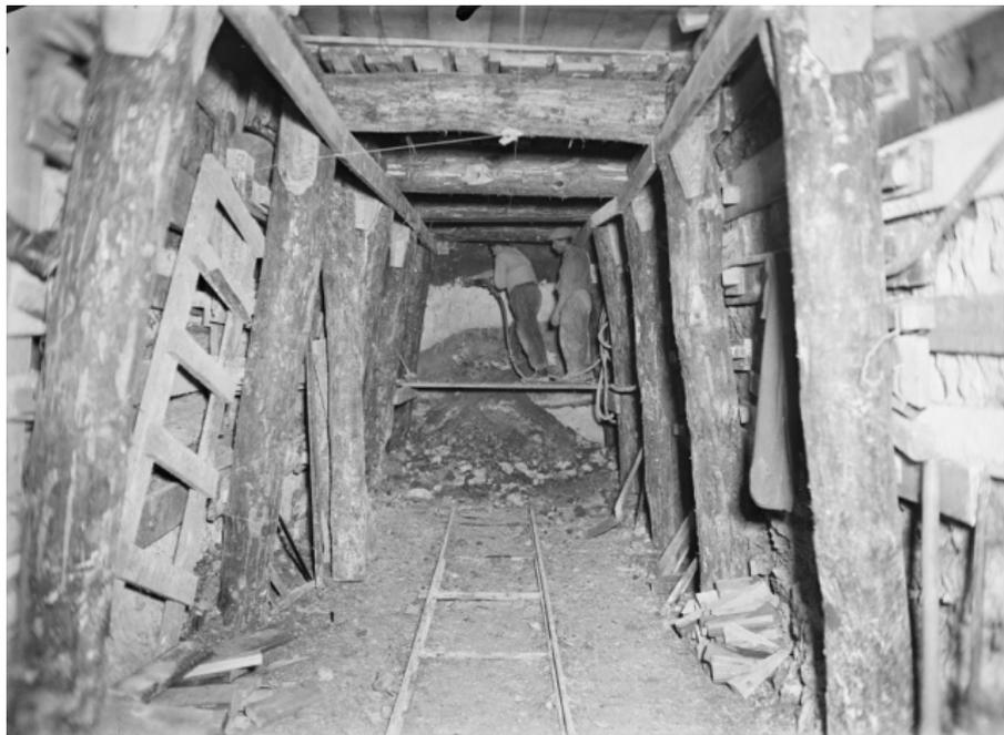
Figure 1.11 Première phase – Galerie d’avancement lors de la création du raccordement des lignes 4 et 12 du métro à Montparnasse en 1934 ©RATP
