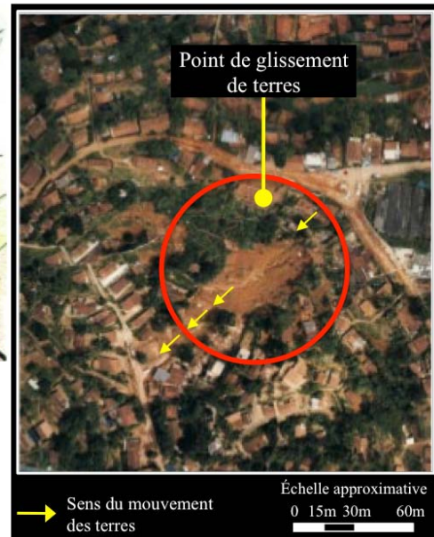
Photo 3-4 : Le Córrego do Boleiro après les accidents en 2000
