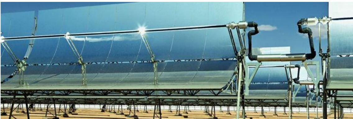
Figure 1.6 Photographie de collecteurs à miroirs cylindro-paraboliques. Source : Schott.
