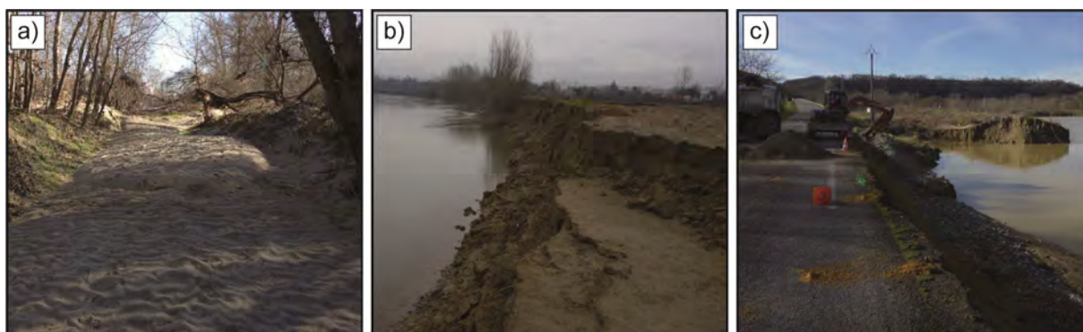
Figure 2.11 : Dégâts causés par la crue du 25-26 Janvier 2014 sur les berges et la plaine de la Garonne toulousaine (photographies diffusées en ligne par l'association Nature Midi-Pyrénées (CATEZH Garonne), auteur non spécifié). a) dépôts de sable sur un sentier de la commune de Verdun-sur-Garonne ; b) érosion de berge à Grenade ; c) déchaussement de route et inondation à Montech.
