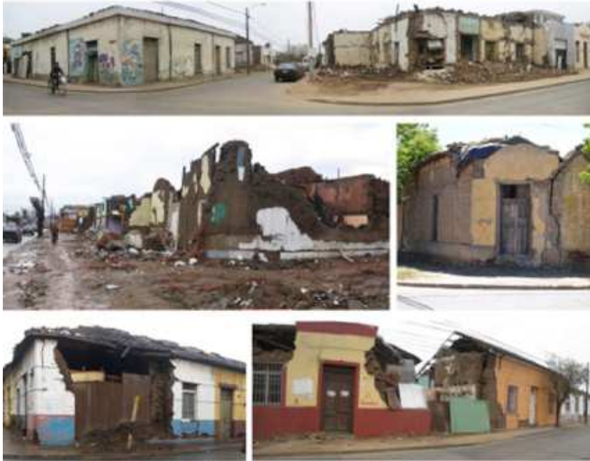
Image 17- Maisons en terre après le tremblement de terre. Source photos: Polis / DUPLA
