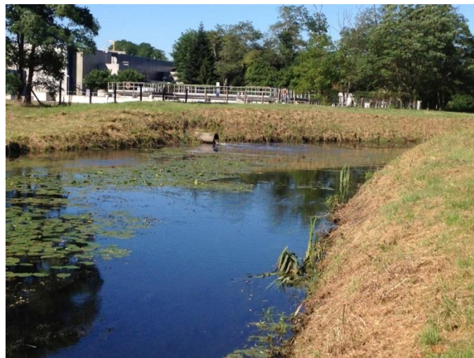
Figure 30. Rejet de la STEP de Cantinolle dans la Jalle de Blanquefort (23 juillet 2012)
