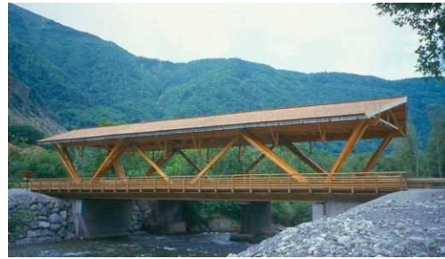
(b) Pont routier des Fayettees à Valbonnais (38)
