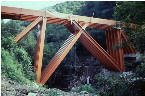
(c) Pont routier de Merle (19)
