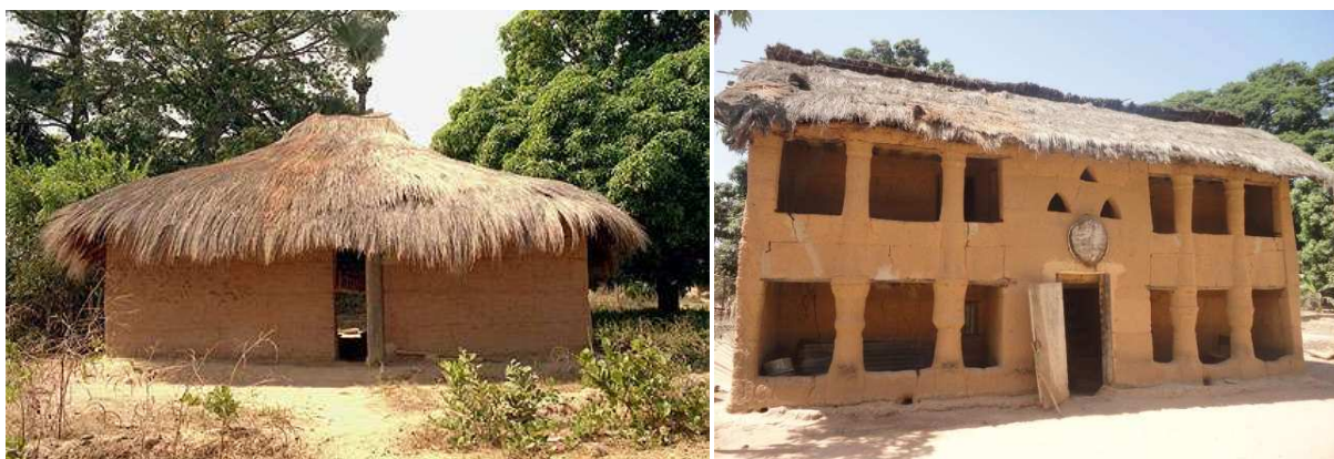
Figure II.4 : l'habitat social casamançais en terre crue (département d'Oussouye)
