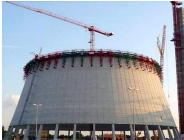
**Figure 1.3** Système de coffrage grim pant
