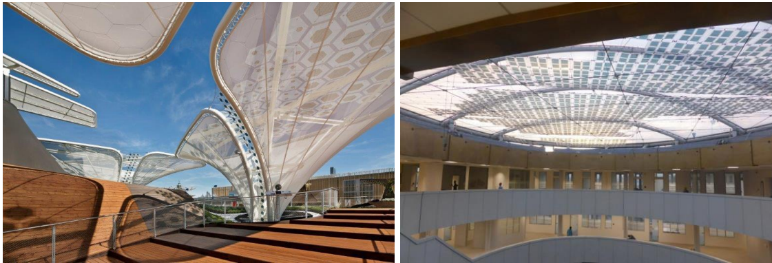
Figure IV.6. Réalisations OPV par l'entreprise BELECTRIC (pavillon allemand de l'exposition universelle 2015 à Milan à gauche, siège de l'Union Africaine pour la paix à Addis Abeba à droite)
