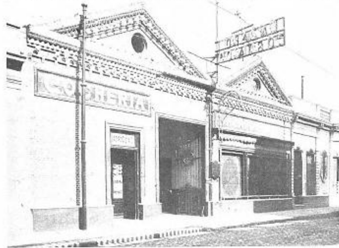
Exterior del edificio
