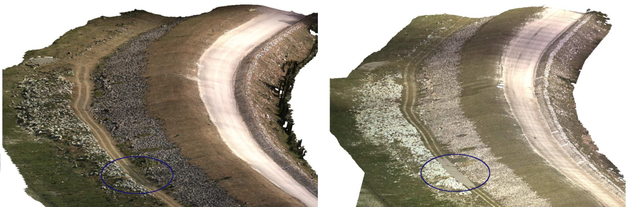
Figure 96: Modèles reconstitués à partir des prises de vue sur Rochemaure en 2013 (à gauche) et 2014 (à droite). La zone encerclée (en bleu) met en valeur l'arrivée d'eau en pied de digue (à gauche), et l'aménagement réalisé pour prévenir d'une détérioration
