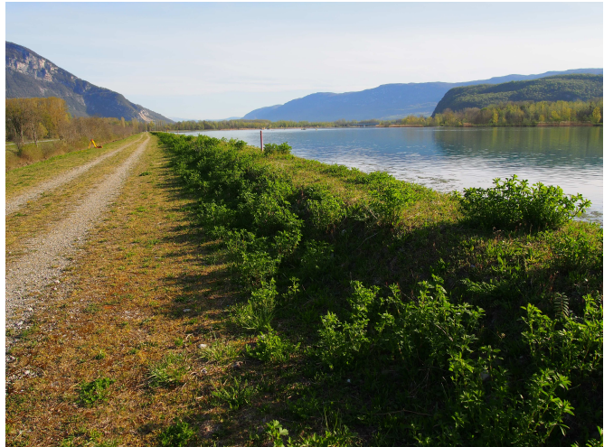
Figure 91: Présence de rejets inadaptés à l'auscultation photogrammétrique aérienne. Pour de meilleurs résultats, une tonte fine est préférable.
