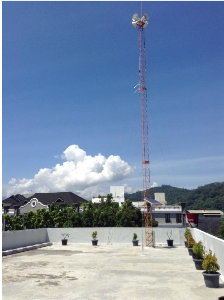
Figure 138. Une des sirènes de tsunami à Padang située sur une des zones refuges verticales.
