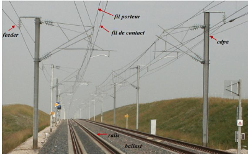
FIGURE 1.1.1 – Panorama du réseau ferroviaire présentant les principaux conducteurs sur-terre. Les câbles de communication et de signalisation sont en général placés le long de la voie, enterrés ou posés dans des caniveaux.
