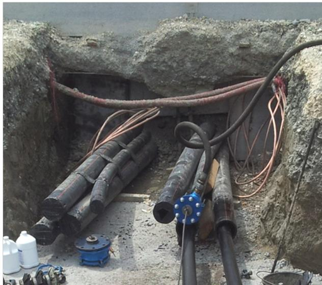
FIGURE 3.6.2 – Prise de vue de l'extrémité de la liaison souterraine du coté de la sous-station.
