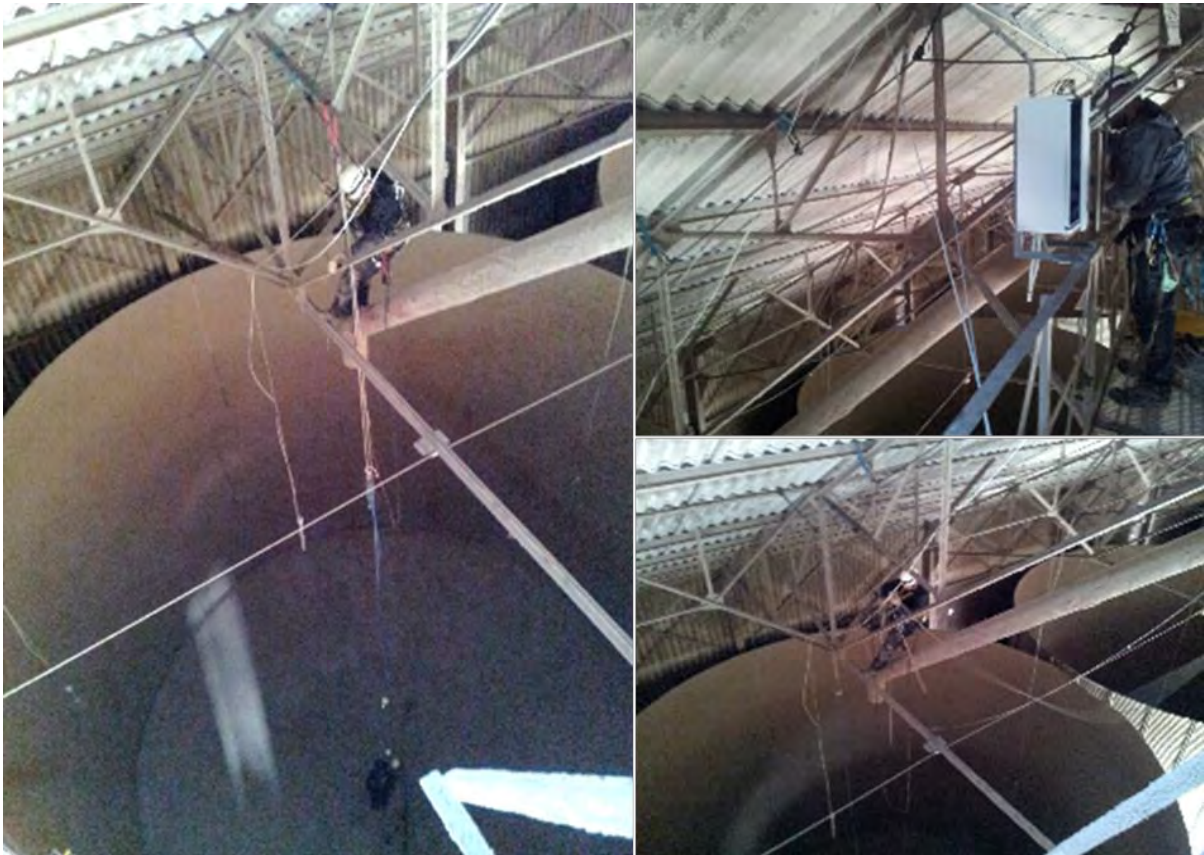
Figure 77 : Installation de la sonde SILOTEST 3
