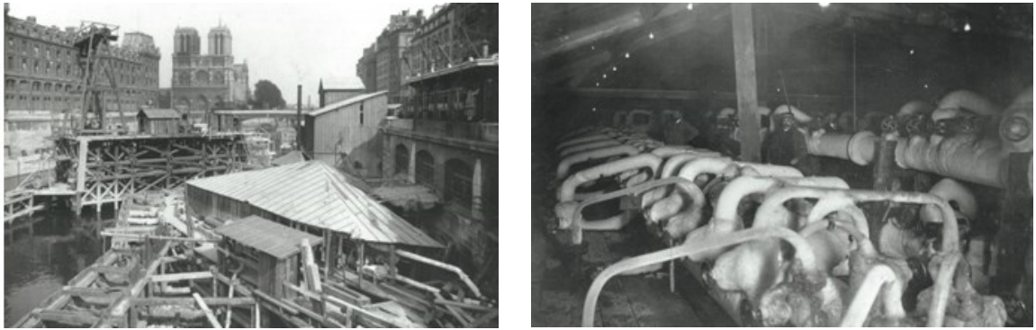
Figure 1-3 : Construction de la traversée sous-fluviale par cheminement horizontal (Cité – Saint Michel, ligne 4). A gauche, emprise de chantier. A droite, usine de congélation pour la consolidation des terrains. (Tricoire, 1999).
