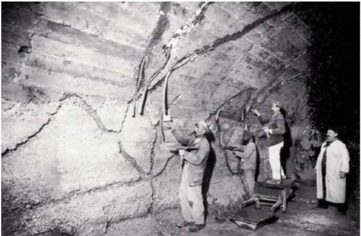
Figure 1-35 : Construction de drains.(Tricoire, 1999).
