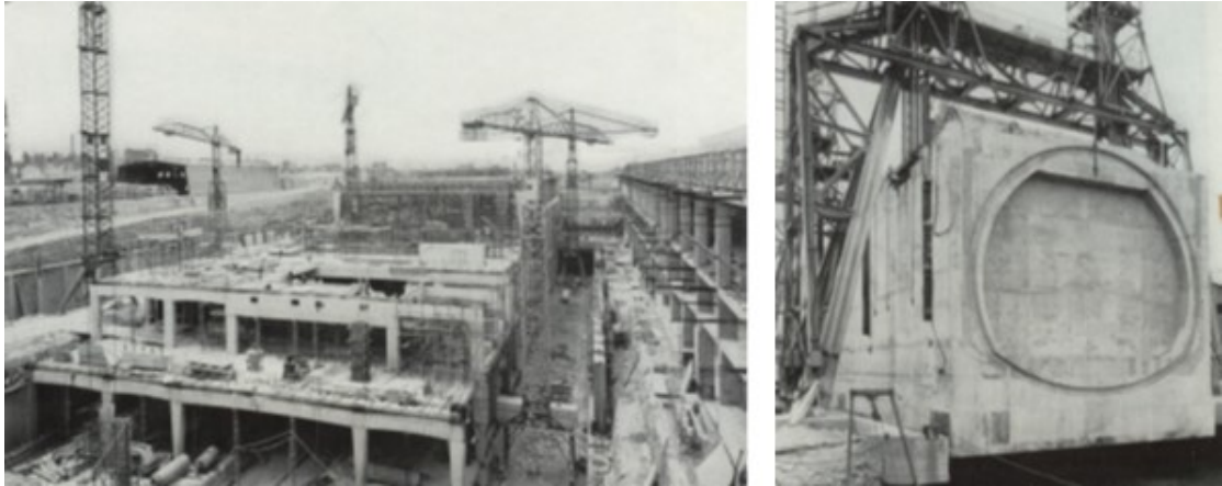
Figure 1-7 : Application du béton précontraint dans la construction du RER. A gauche, construction de la gare de La Défense. A droite, caisson en béton précontraint de la traversée sous-fluviale entre Courbevoie et Neuilly. (Douroux, 2012)
