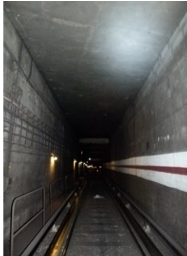
Figure 1-16 : Ouvrage cadre en béton armé (extrémité ligne 1)
