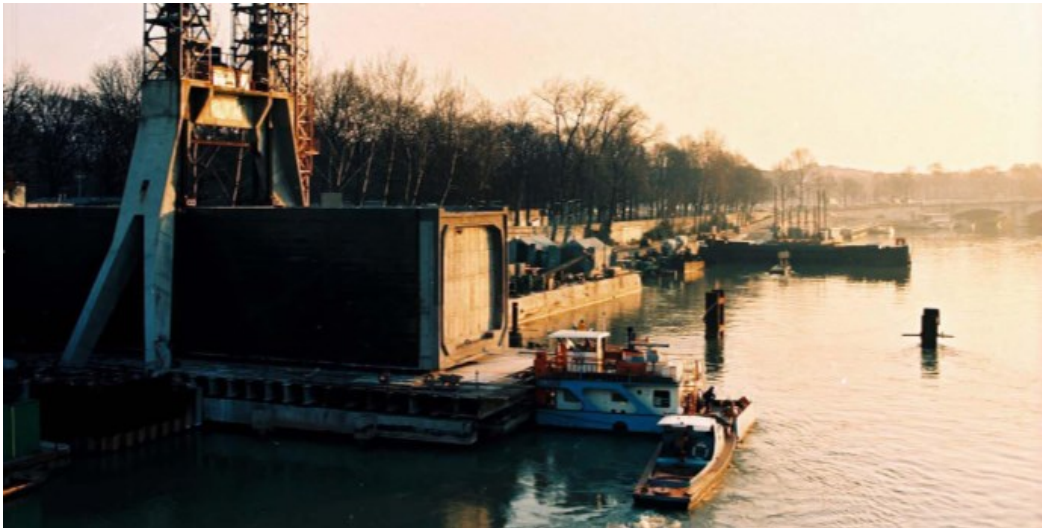
Figure 1-12 : Caisson en béton précontraint pour la traversé sous-fluviale de la ligne 13 à Invalides (Douroux, 2012)
