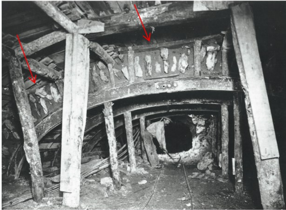
Figure 1-26 : Construction de la voûte. (Tricoire, 1999).
