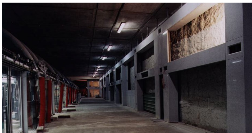
Figure 1-15 : Tranchée couverte en béton armé. (Douroux, 2012)
