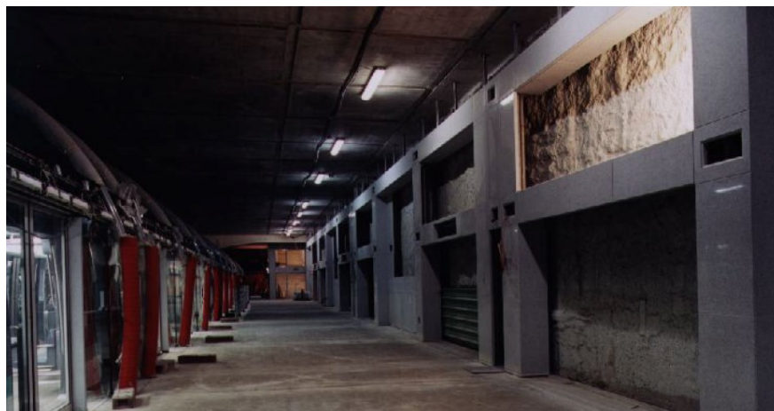
Figure 1-15 : Tranchée couverte en béton armé. (Douroux, 2012)
