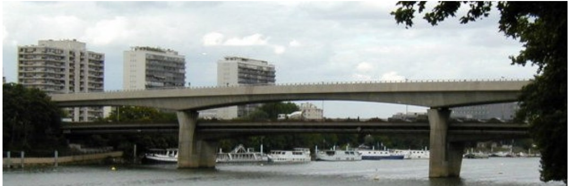
Figure 1-18 : Viaduc en béton précontraint. (Douroux, 2012)
