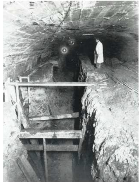
Figure 1-28 : Terrassement du « stross » et coffrage pour la construction des piédroits. (Tricoire, 1999).
