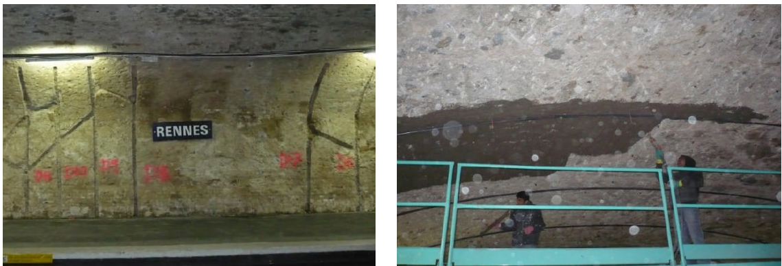
Figure 1-37 : A gauche : système de drains en patte d'oie. A droite : projection du mortier de ciment pour la réfection d'enduits. (Duarte, 2012)
