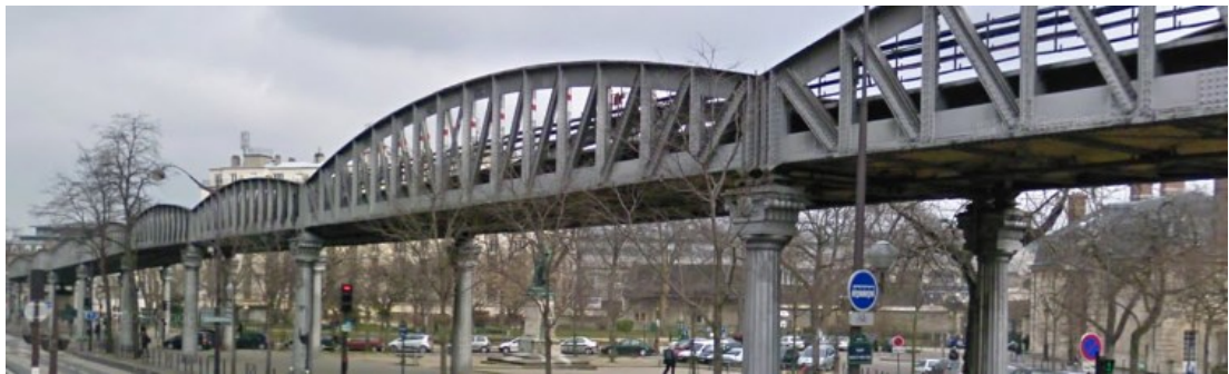
Figure 1-19 : Viaduc métallique de type courant (Combes, 2014)
