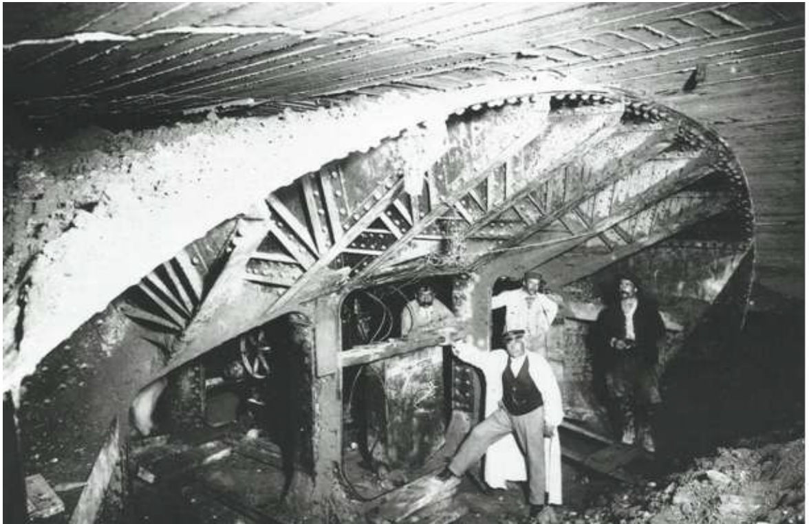
Figure 1-11 : Bouclier de percement pour la construction des tunnels maçonnés. (Tricoire, 1999)
