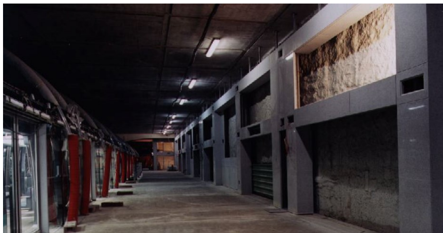
Figure 1-15 : Tranchée couverte en béton armé. (Douroux, 2012)
