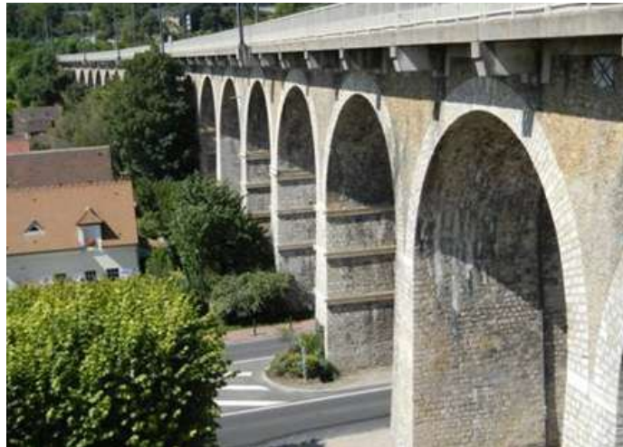
Figure 1-5 : Viaduc de La Vallée, construit en 1845 et réadapté pour l'exploitation du RER A en 1972.
