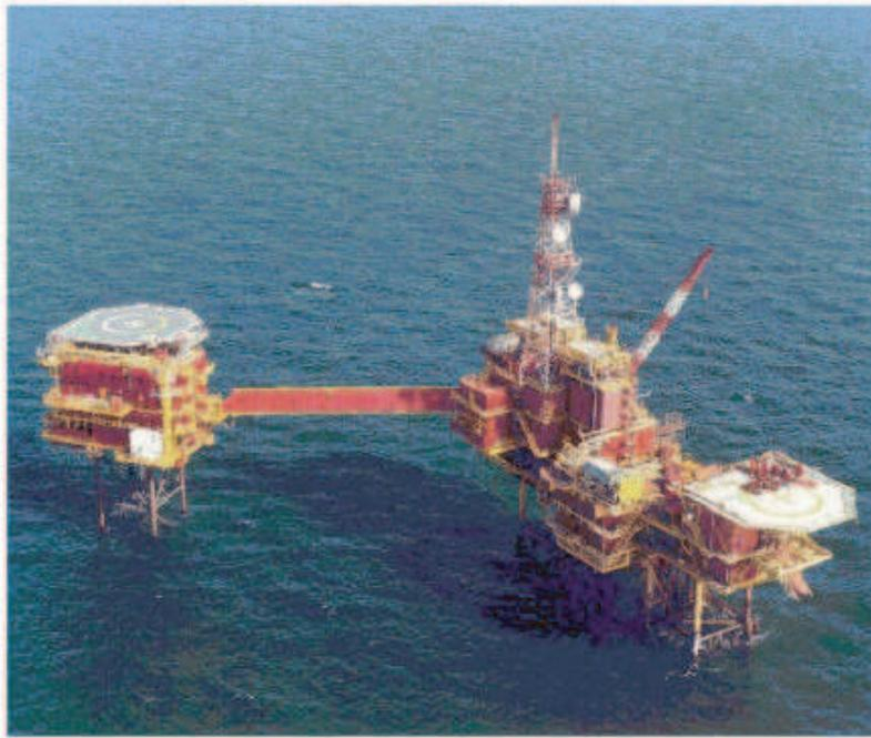
Fig. 1 – Plate-forme pétrolière de type 'Jacket'.
