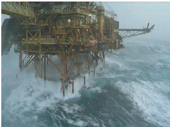
Fig. 3.1 – : Structure jacket sollicitée par une houle de tempête.
