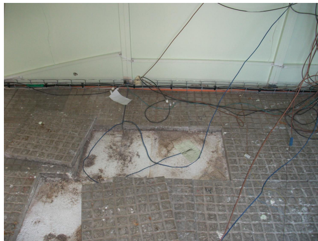
Figure III.9 : Capteurs de mesure de température et flux au niveau du plancher
