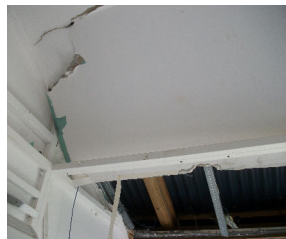
Figure III.12 : Démontage des plaques de placoplâtre.
