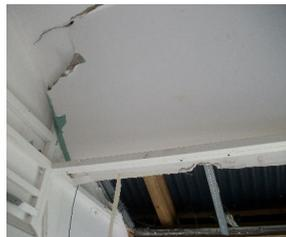
Figure III.12 : Démontage des plaques de placoplâtre.
