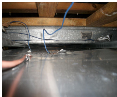
(c) Mesure de la température et de la température radiante flux de la surface « extérieure ».
