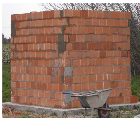
(d) Cabine en brique alvéolaire
