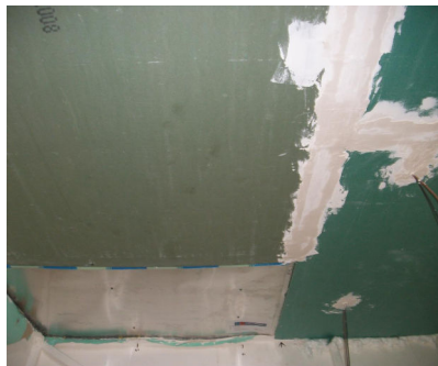
(a) Pose des MCP faux-plafond.
