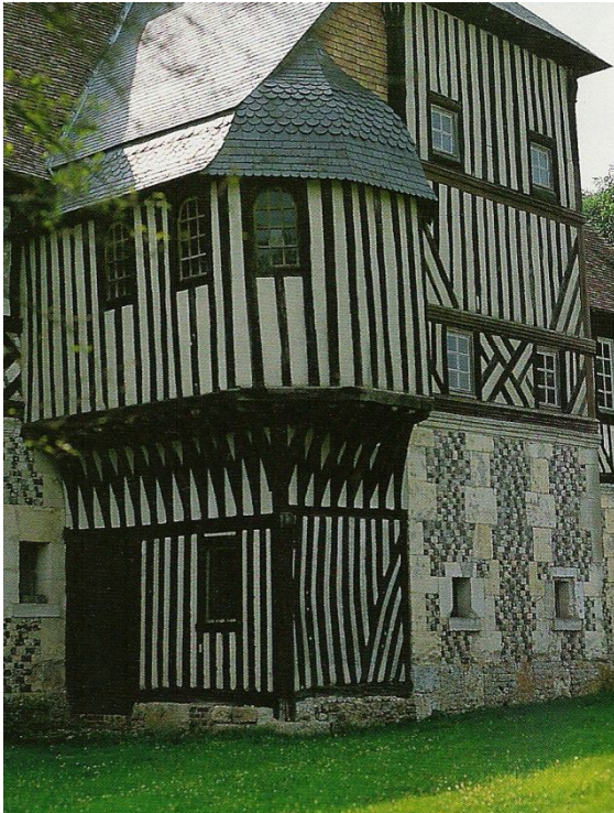
Chapelle du manoir de St Léger posée en encorbellement et accrochée à la tour d'escalier
